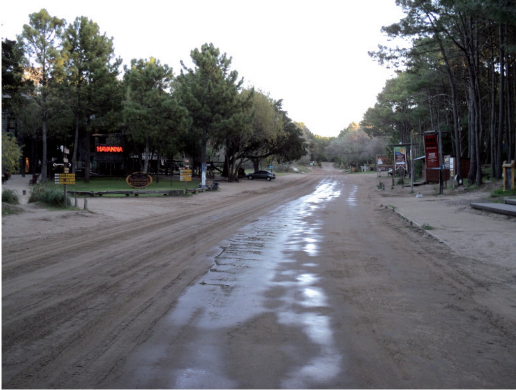
Fig. 4. Calles sin pavimentar
