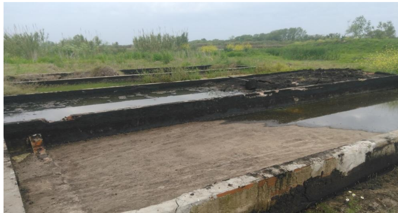
Figura 3. Piletas de recolección de suelos contaminados con hidrocarburos, para disposición final.
