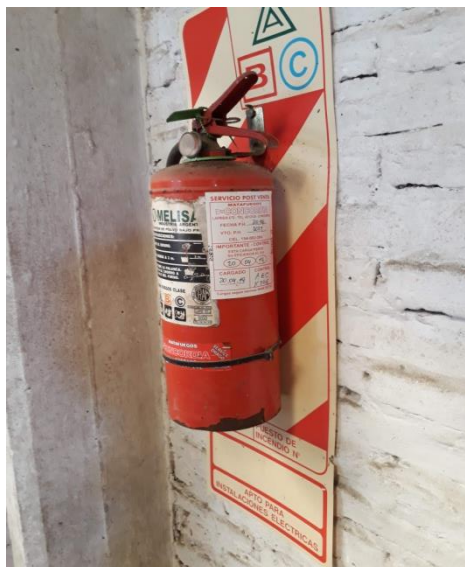
Figura 5.1.4. Matafuego con ubicación fija y normalizada.
