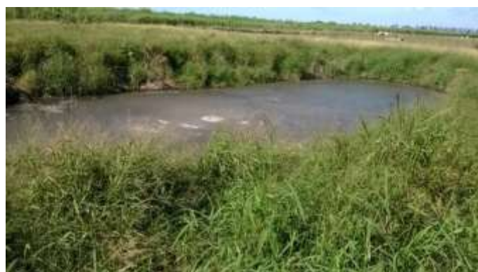
Figura 13. Laguna recolectora de purines provenientes de la etapa de recría (capacidad 600 m 3 ).
