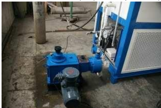
Imagen 35 – Sistema de inyección del agente espumante
