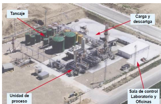
Fig. 3-8. Vista aérea de las instalaciones industriales de Ecolube
