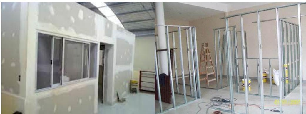
Ilustración 5.35 | Sistema construcción en seco
