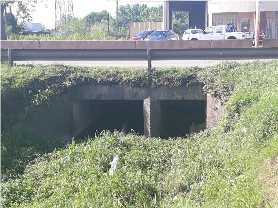
Ilustración 3.10 | Relevamiento Fotográfico: Alcantarilla Rectangular Tramo 2
