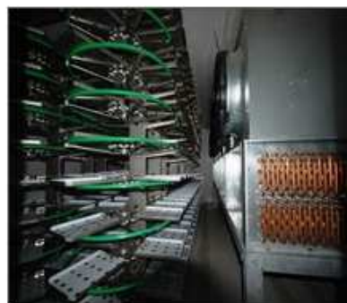
Raffreddamento rapido e Tunnel -40°C
