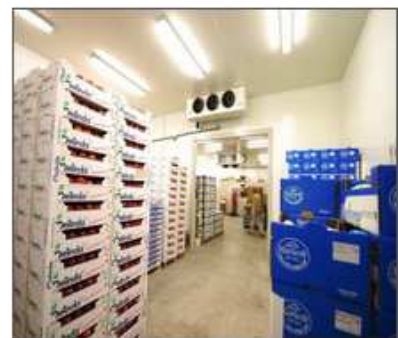
Celle di conservazione 0/+4°C
