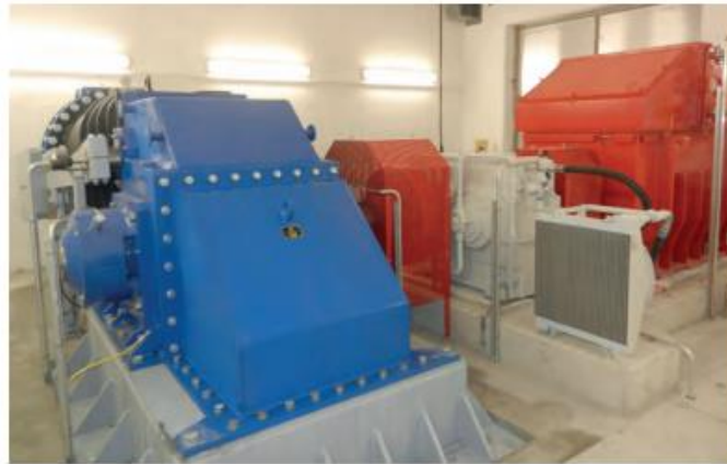
Imagen 3-2 Instalación turbina Ossberger
