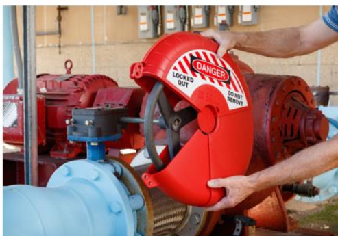
Imagen 6-3 Elementos de bloqueo para tareas de mantenimiento seguras
