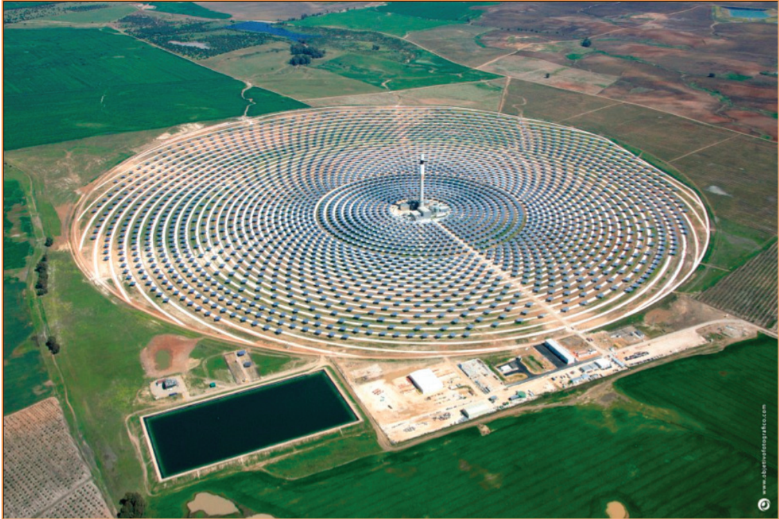
Fig. 4. Vista aérea de Gemasolar (17MWe) Fuente: Torresol Energy S.A.
