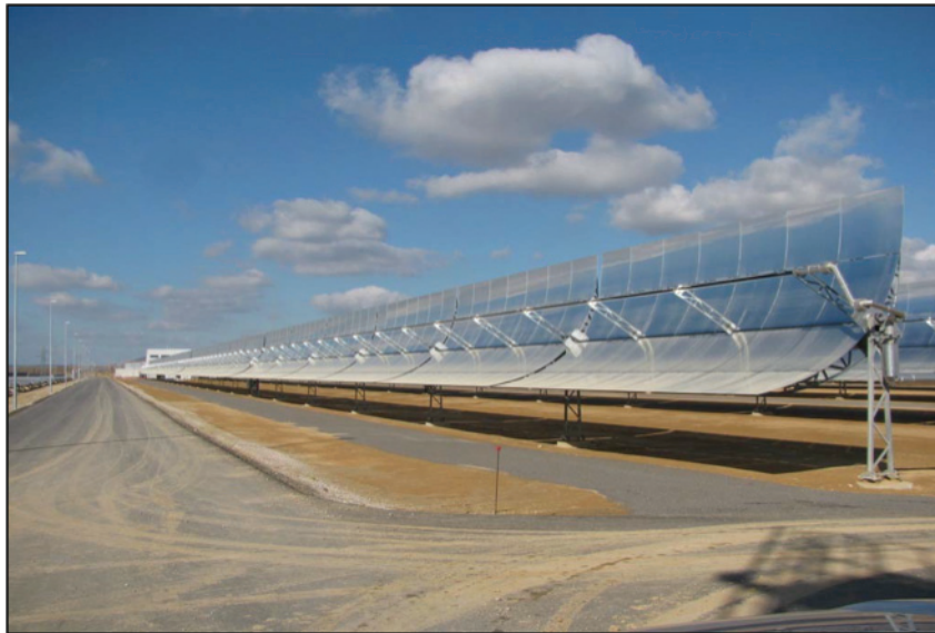
Fig. 2. EXTRESOL 1, 2 & 3 Parabolic Trough Plants 50 MWe, Badajoz- España. Fuente: SENER
