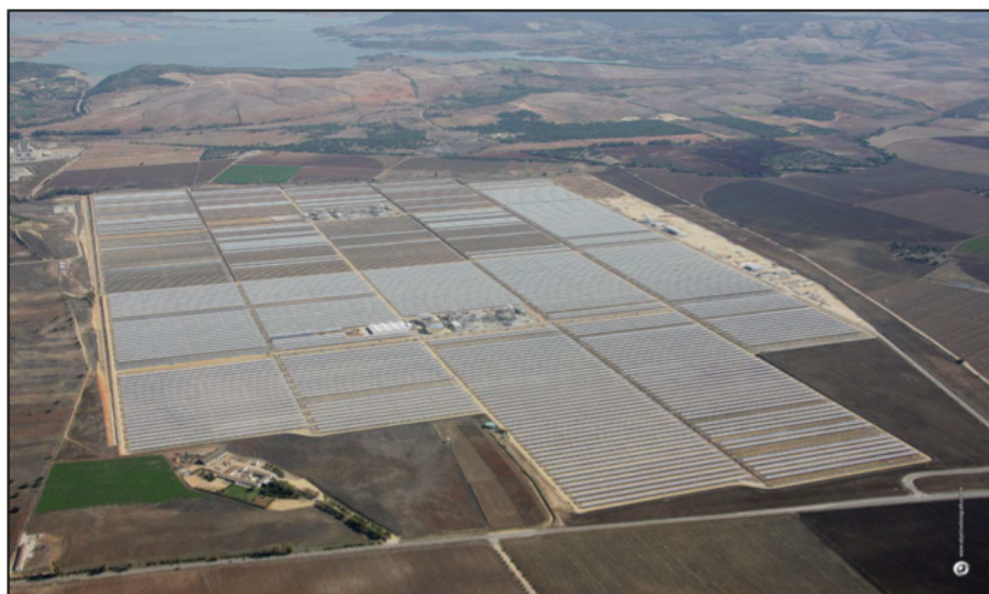
Fig. 1. EXTRESOL 1, 2 & 3 Parabolic Trough Plants 50 MWe, Badajoz- España. Fuente: SENER
