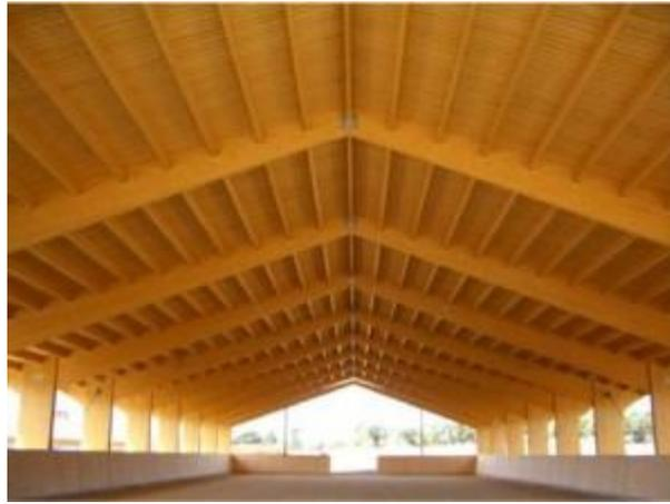
**Fig. 21.** Sistema estructural con pórticos triarticulados de madera
