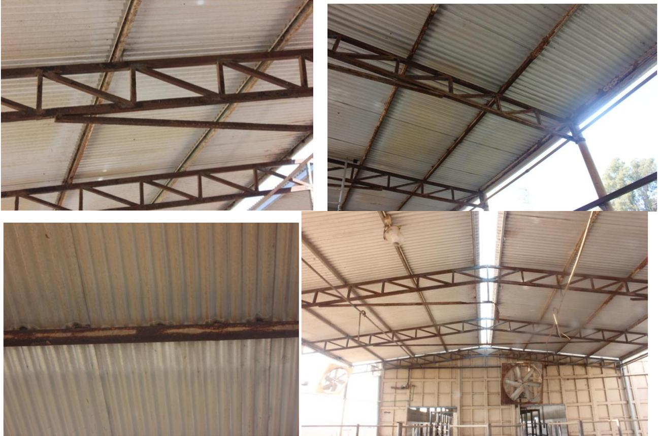
**Fig. 8.** Ejemplos de corrosión
