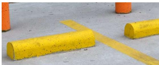
**Figura 4.7:** Demarcación vial y topes para ruedas.
