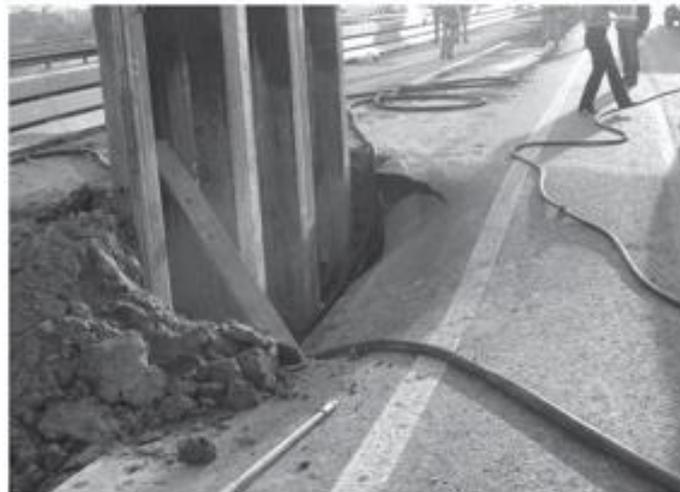
**Fig. 2.** Excesivo asentamiento durante la ejecución de una pila por vibración
