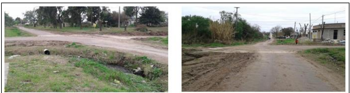
Fotos en primer plano a calle transversal Gdor. Mihura. También pueden verse los badenes de hormigón y el caño de PVC; todos ellos a retirar.
