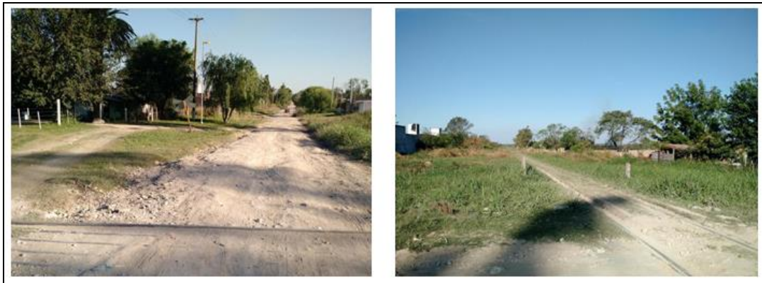
Fotos en primer plano a calle transversal Gdor. Mihura a la altura de la vía férrea que la intersecta perpendicularmente. Se observan las cunetas a profundizar y la pendiente de la calle en cuestión a esa altura.
