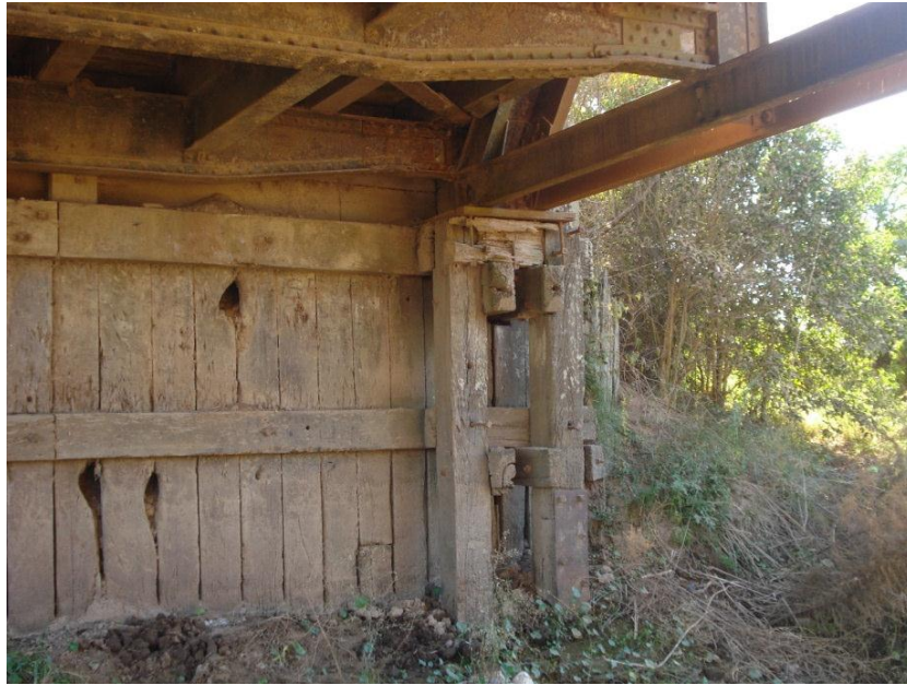
Figura 8: Columnas de quebracho.
