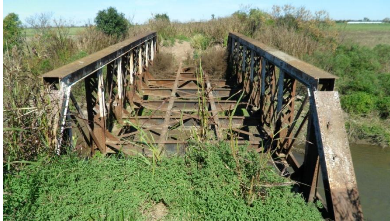
Figura 11: Estado actual del puente.
