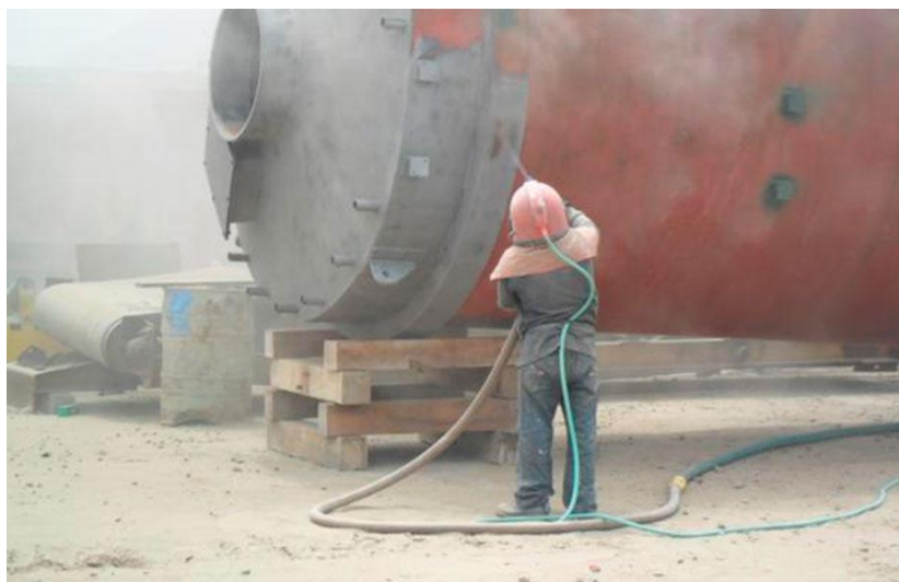
Figura 55: Sandblasting o arenado
