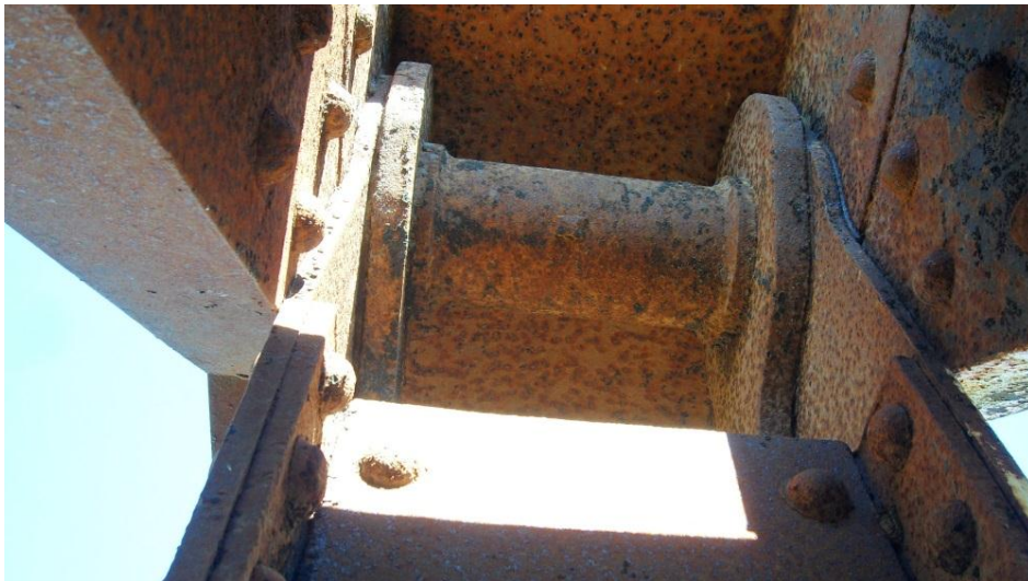
Figura 52.b: Roblón recubierto.
