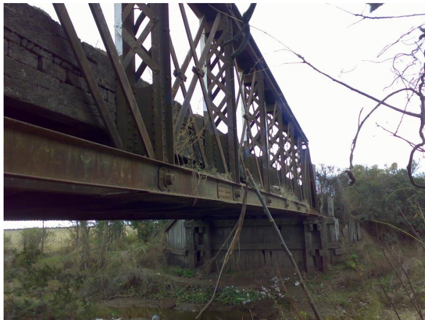
Figura 7: Vista estribo norte.
