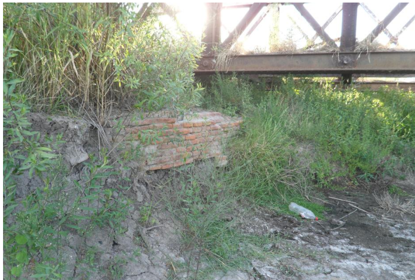
Figura 9: Revestimiento de mampostería.
