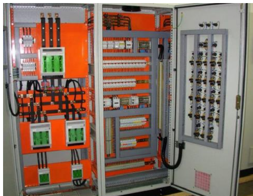
Figura 12.3 - Tablero eléctrico.
