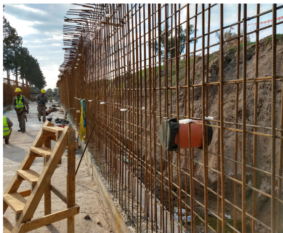
Fig. 2. Visita de obra en la ciudad de Rafaela
