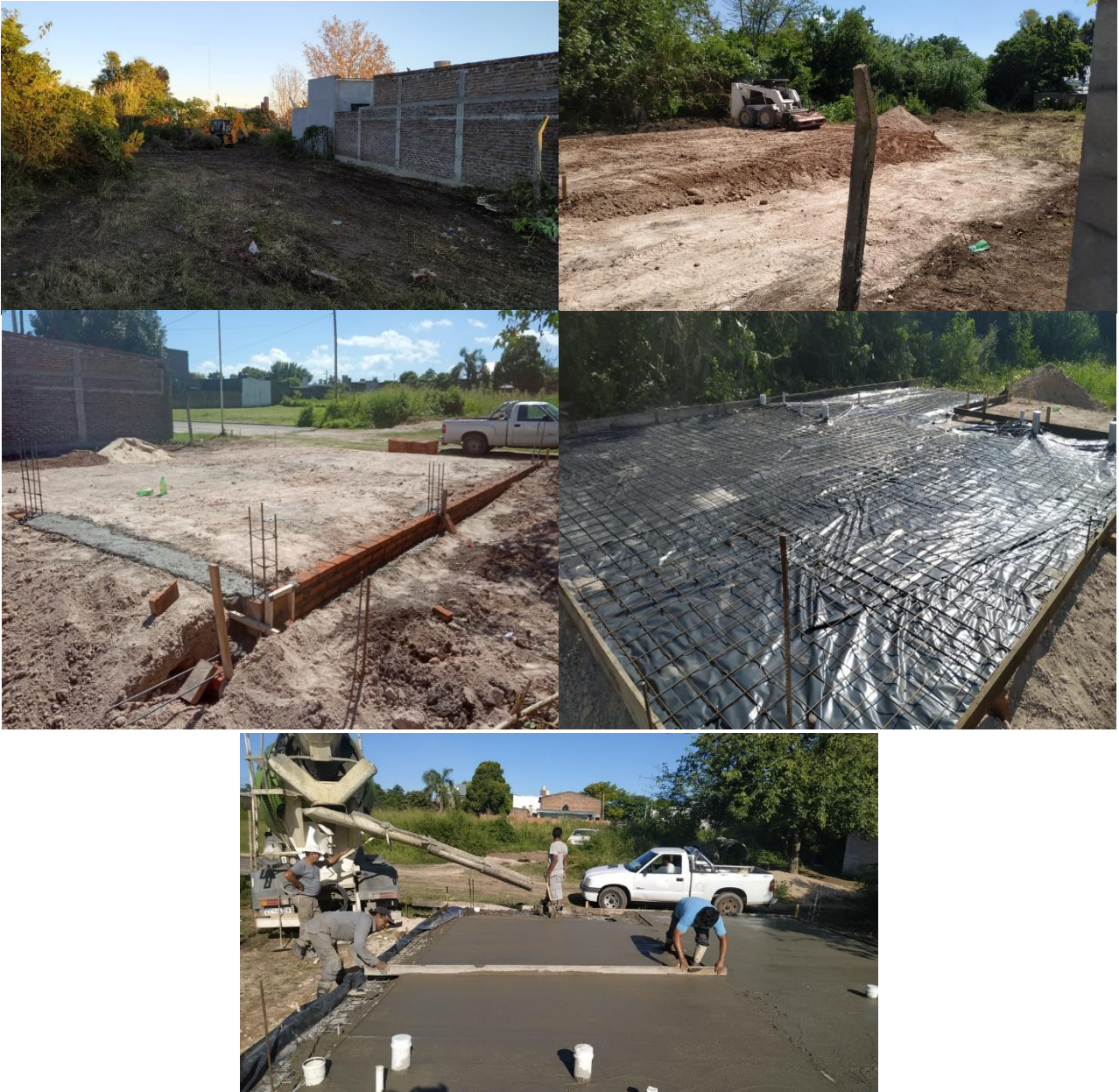
Foto 1. Construcción del prototipo VES: Fase fundación – 1. Limpieza de terreno; 2. Relleno y nivelación; 3. Muro de contención para platea; 4. Hierros, sanitarios y aislación; 5. Platea.
