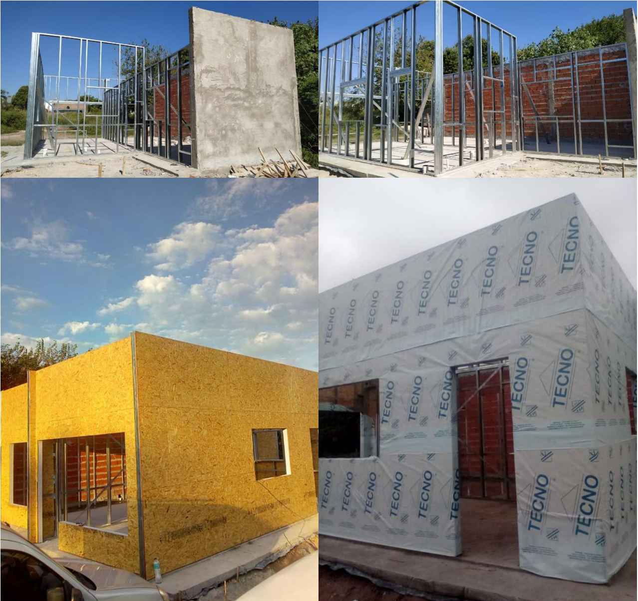
Foto 2. Construcción del prototipo VES: Fase estructura – 1. Medianera y estructura de acero; 2. Estructura; 3. Rigidización OSB; 4. Barrera de agua y aire.
