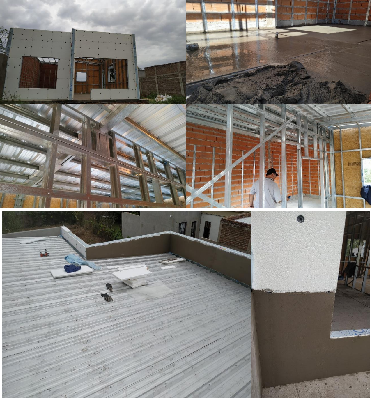
Foto 3. Construcción del prototipo VES: Fase Instalaciones y aislaciones – 1. Aislación térmica y acústica; 2. Carpetas; 3. Cubierta; 4. Revestimiento exterior.
