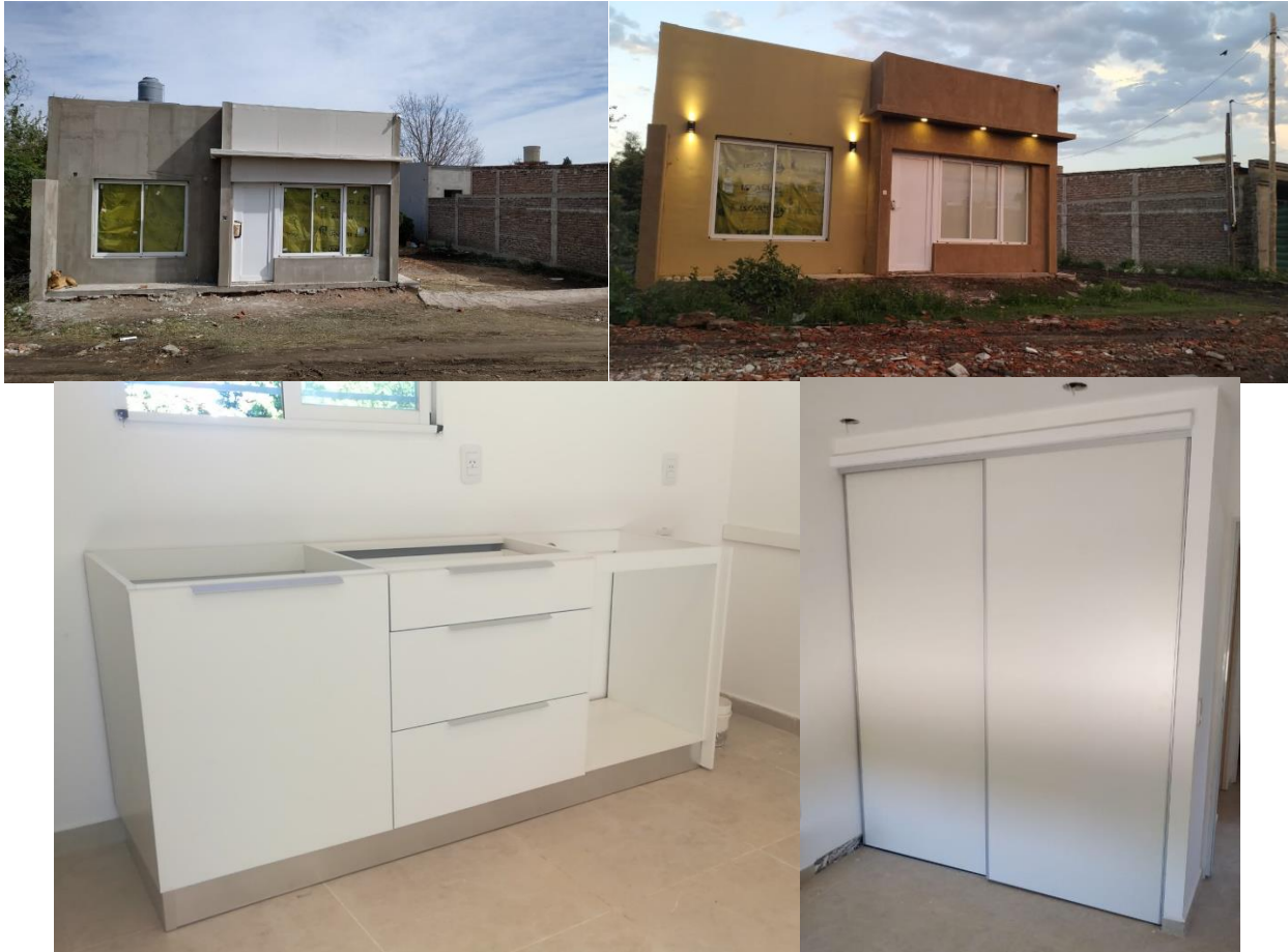
Foto 4. Construcción del prototipo VES: Fase Terminaciones – 1. Base coat; 2. Revestimiento exterior; 3. Amoblamientos.
