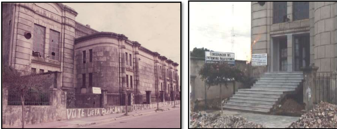
Ilustración 7 – Fotografías de la fachada de la facultad por calle Salta.
