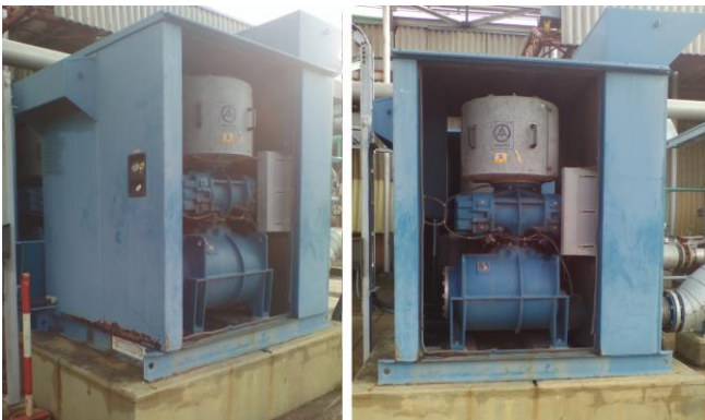
Fig. 1. Un soplante típico montado en su gabinete.
