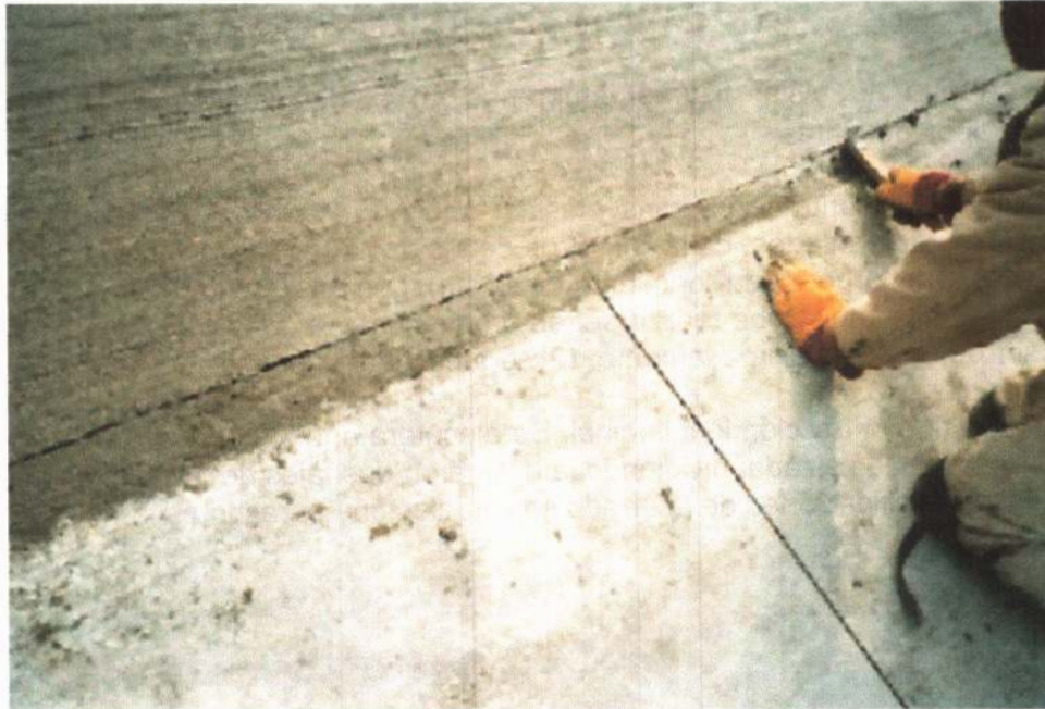
Figura 8-8: Junta de construcción.
