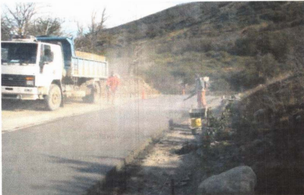
Figura 8-5: Aplicación de membrana con pulverizadores tipo mochila a explosión.
