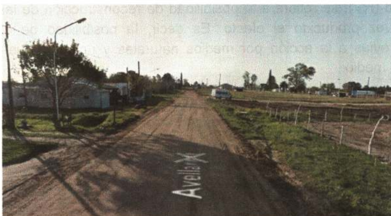
Figura 9-4: Sector Calle Avellaneda a pavimentar
