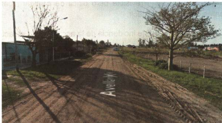
Figura 9-3: Sector Calle Avellaneda a pavimentar
