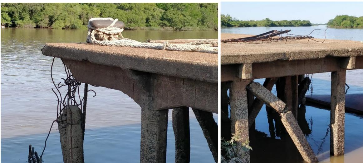
*Figura 37: Deterioro en los muelles 5 a 13. Fuente: elaboración propia*
