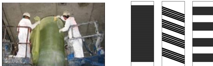
Figura 1: Técnica y diferentes esquemas de refuerzo con FRP (Teng et al. , 2002)
