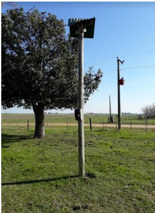
“Tendido” electrico Escuela Nro 55 - Colonia Los Ceibos
