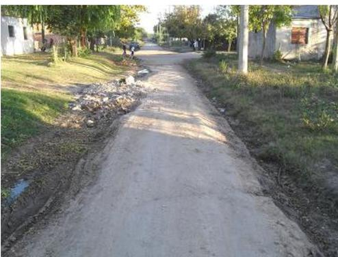
Fig. N° 3.12- Cunetas en mal estado en Villa Itapé
