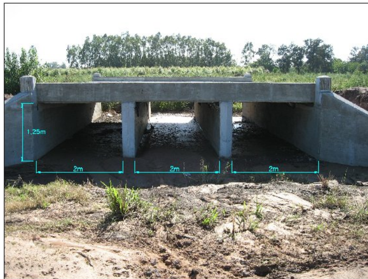
Figura nº 06-02-02: Alcantarilla aguas arriba
