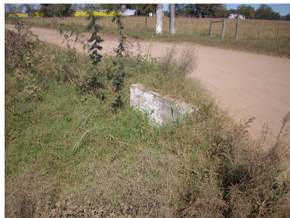
Figura nº 06-01-05: Entubado en intersección calle Estrada esquina Sourigues
