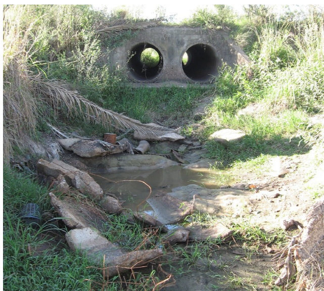
Figura n° 06-02-01: Alcantarilla existente s/ calle Estrada
