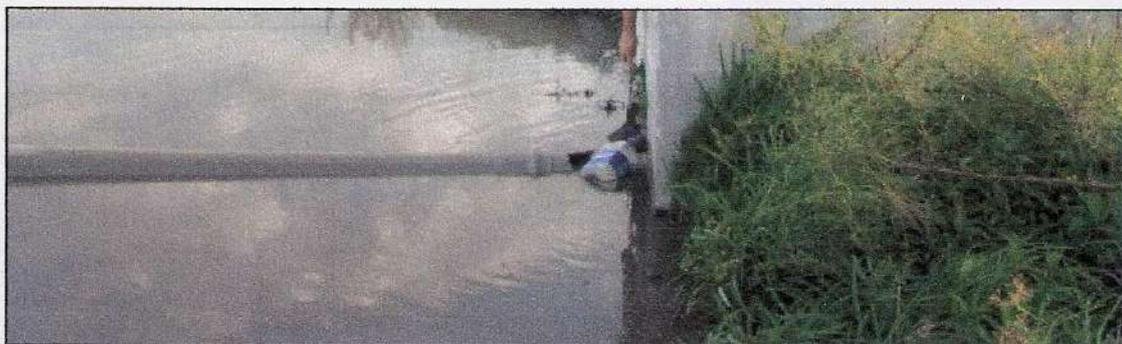
**Figura 6-13. Imagen de la rotura de la cañería de entrada en lagunas de sistema Este.**
