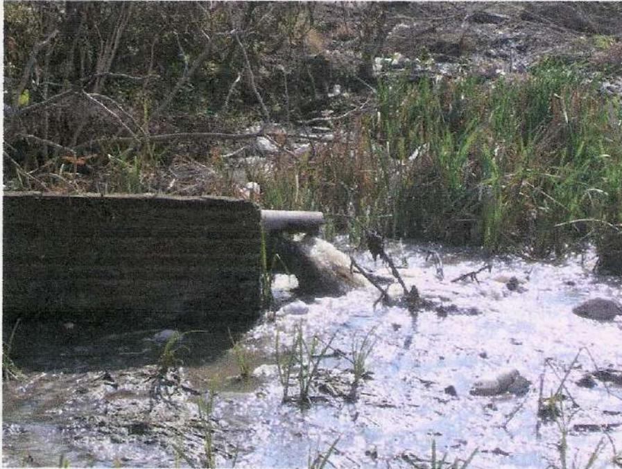
Figura 4-8. Sistema de ingreso del efluente.
