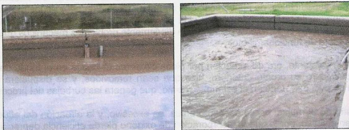
Figura 5-32. Funcionamiento del digester de barros.
