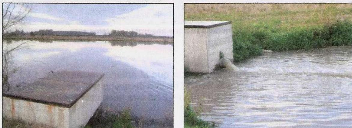
Figura 6-8. Estructura de entrada.
