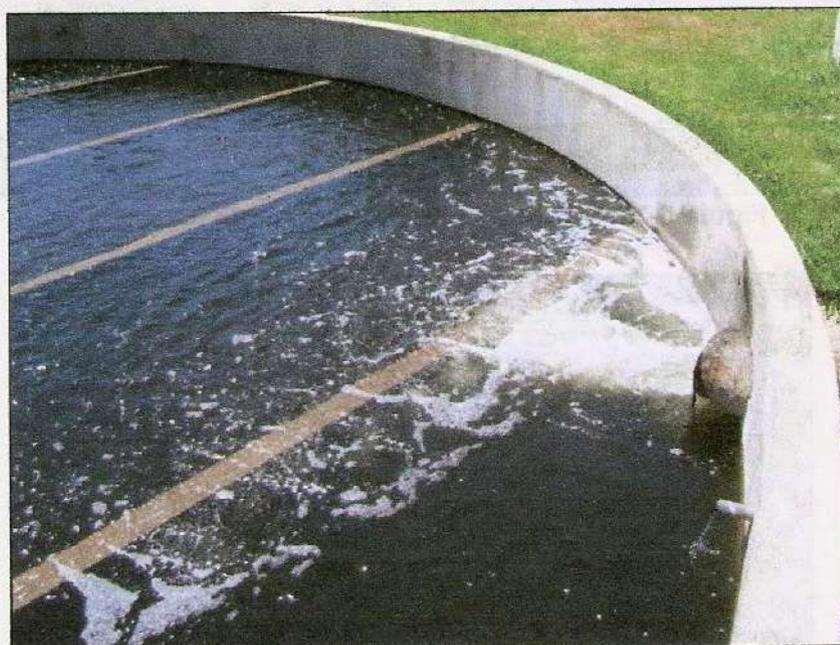
Figura 5-36. Exceso de caudal en cámara de contacto.
