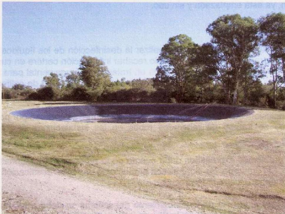
Figura 8-11. Pileta de prueba de aireadores.
