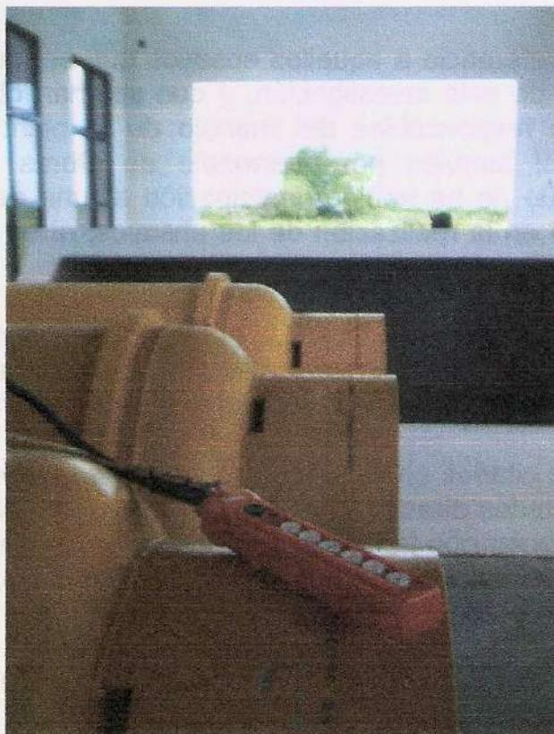
Figura 3-16. Sala de cloración, imagen de los recipientes con el cloro.
