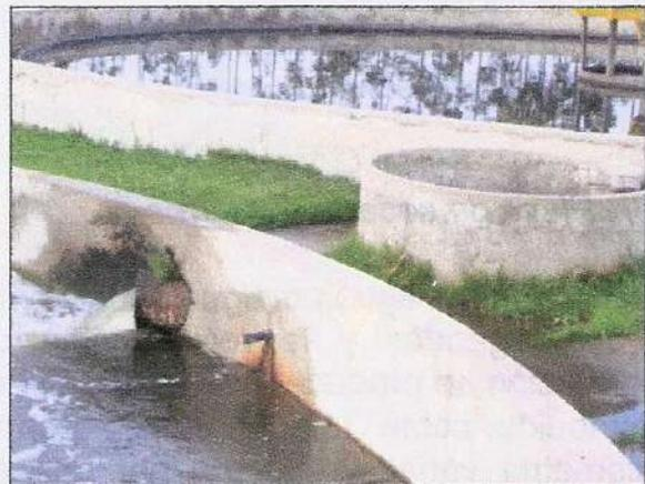
**Figura 5-12.** Imagen de la cámara de contacto y cloración. Ingreso del efluente y de la vena de cloro en la cámara de contacto.
