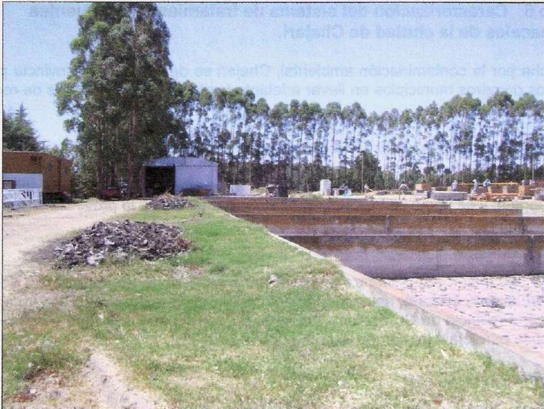
Figura 5-38. Extracción de residuos de las playas de secados.
