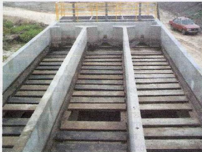
Figura 3-11. Vista del desarenador
