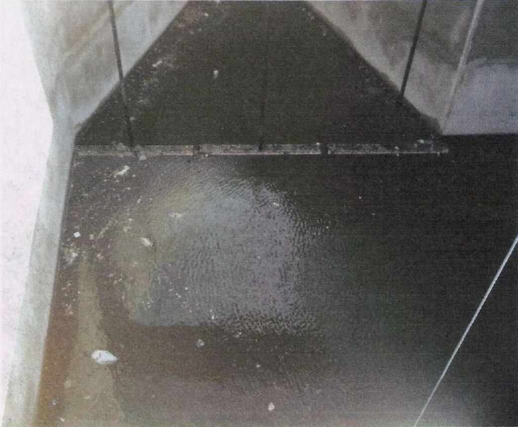
Figura 8-9. Cámara colapsada por ingreso de efluentes en días lluviosos.
