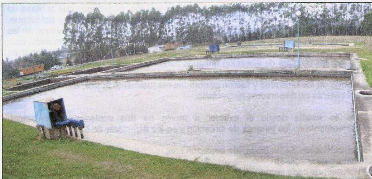
Figura 5-7. Imagen de los tanques de aireación.
