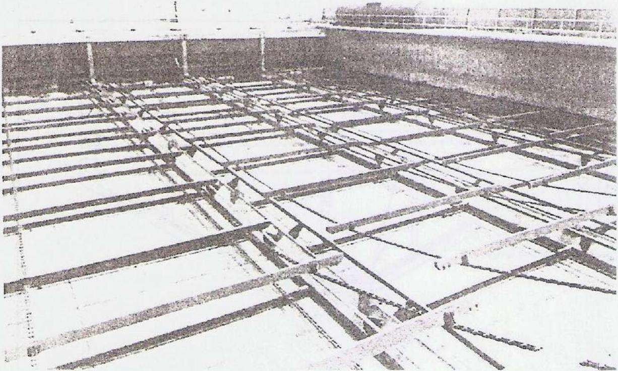
**Figura 2-11. Tanque de decantación rectangular vacío en el que se aprecian los rascadores del fango.**
