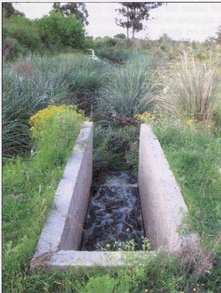
Figura 6-11. Estructura de salida.
