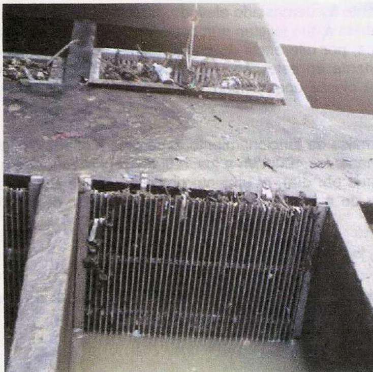
Figura 3-9. Vista de la cámara de rejas y canasto de recolección de residuos.
