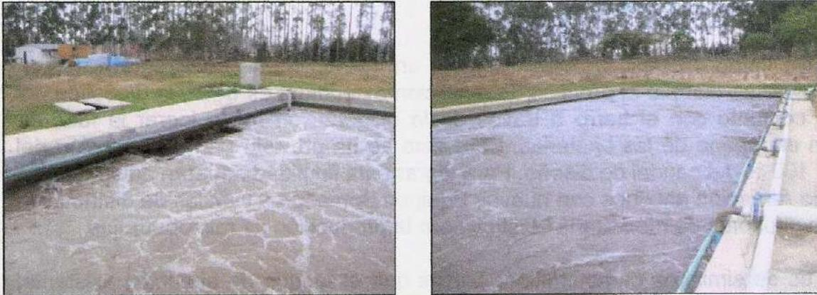
Figura 5-21. Imágenes del funcionamiento de los estanques de microburbujas.
