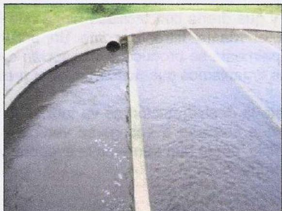
**Figura 5-13.** Imagen de la cámara de contacto en hora pico de trabajo.
