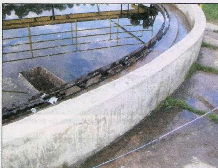
Figura 5-35. Estado de las tolvas de recolección de residuos de los sedimentadores.
