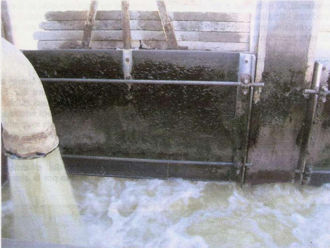
Figura 8-3. El caudal de las cañerías de impulsión que producen las salpicaduras y gases.
