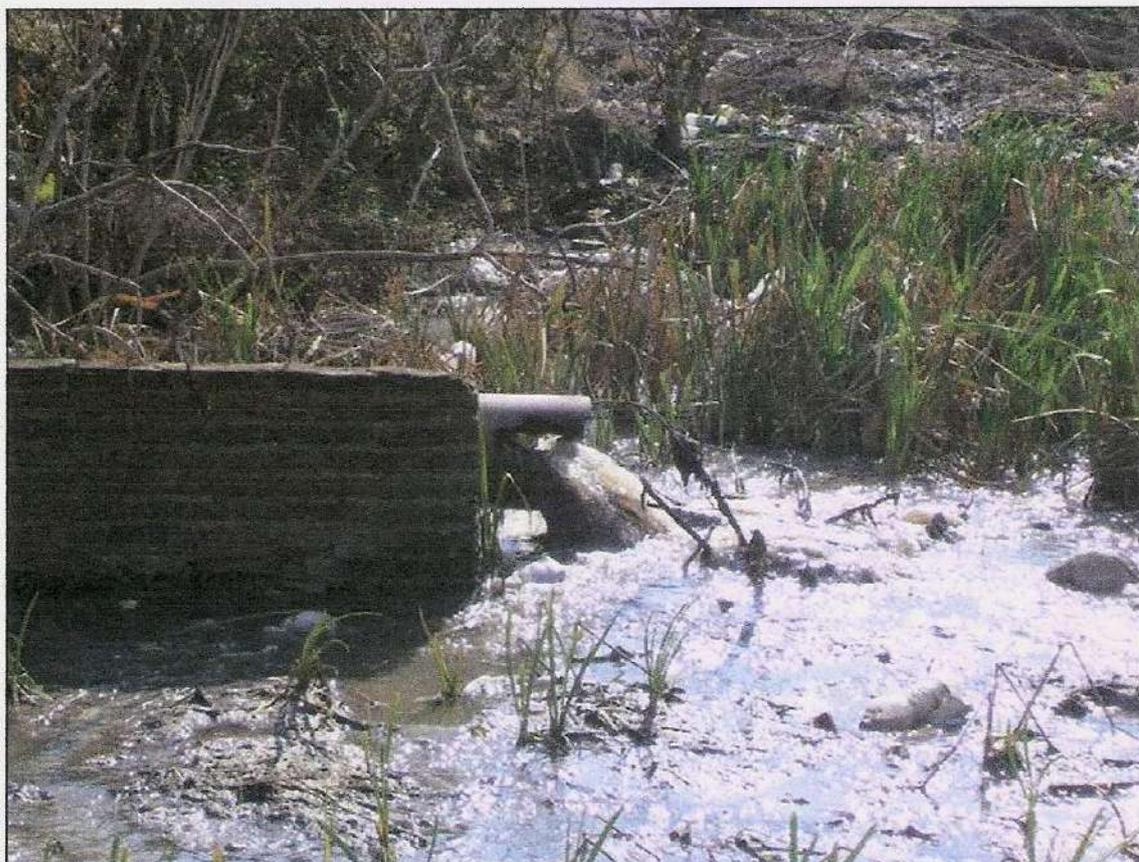
Figura 4-4. Estructura de ingreso del efluente al estanque anaerobio.
