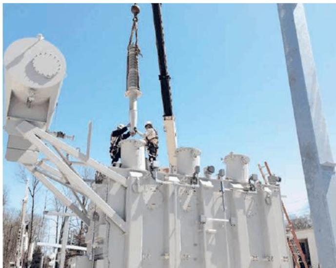
Fig. 3.9 Montaje de Aisladores
