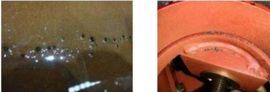
Fig. 3.8 Partículas metálicas en transformador.
