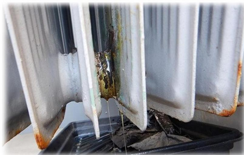
Fig. 3.16 Fuga de aceite de un transformador corroído.
