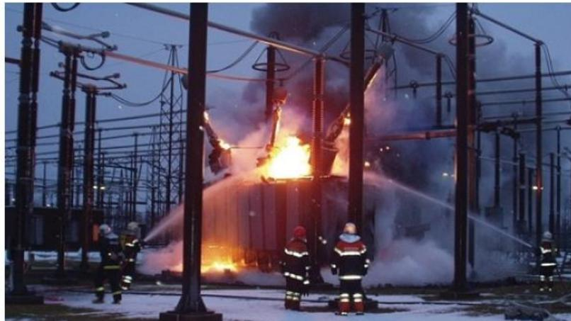
Fig. 3.1 Falla de un transformador
