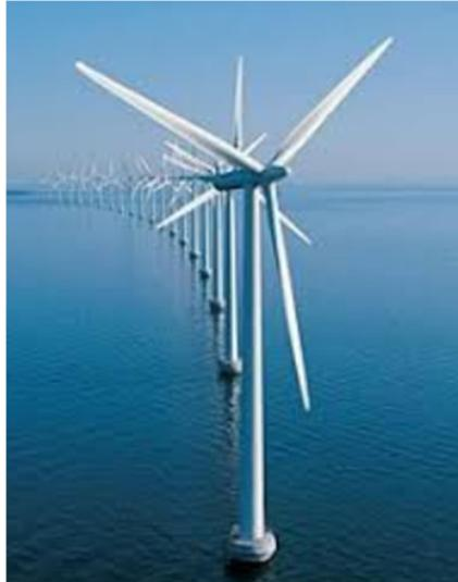
*Fig n° 6: Parque eólico instalado en el mar de Noruega. Instalado en forma de arco para evitar la perturbación del viento*
