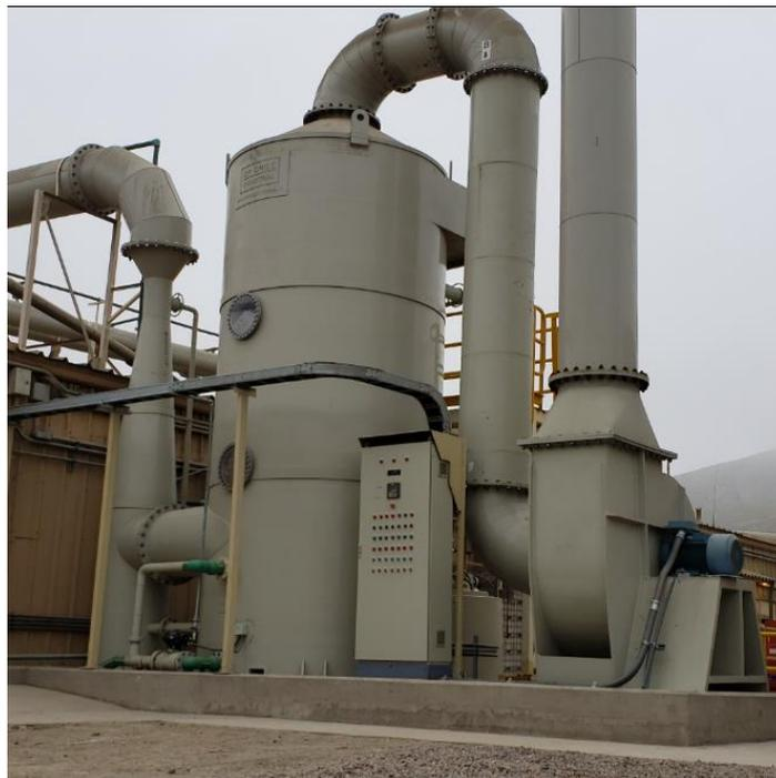
Son columnas verticales que se llenan con empaque de superficie grande. El líquido se distribuye sobre éste y escurre hacia abajo a través del lecho empacado, de tal forma que expone una gran superficie al contacto con el gas, que fluye a contracorriente de forma ascendente dentro de la columna.
