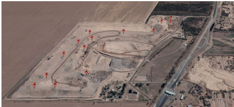
Figura 2. Cámaras de venteo del relleno sanitario
