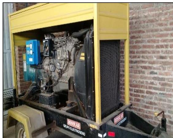
Foto 1.72 - Generador montado sobre carro.
