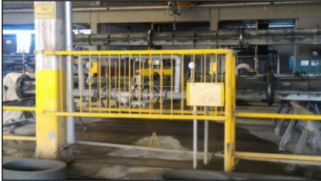
Foto 1.66 – Estación de Rebaje de presión
