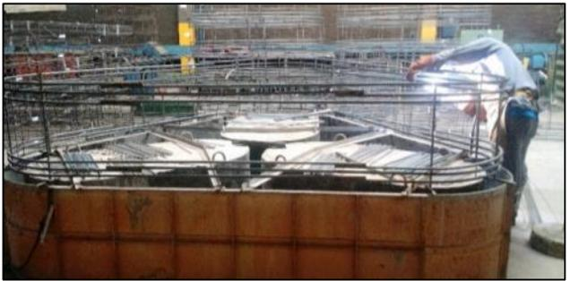
Foto 1.30 - Encofrado de accesorios
