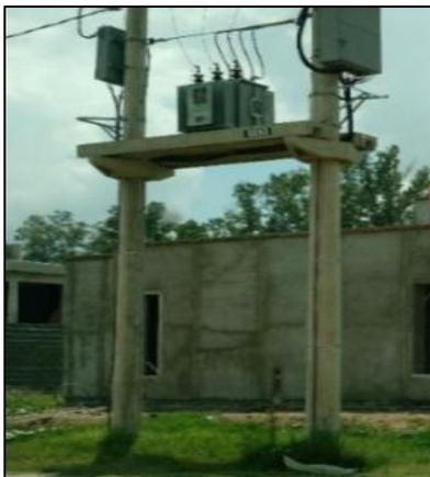
Foto 1.56 - Subestación Transformadora
