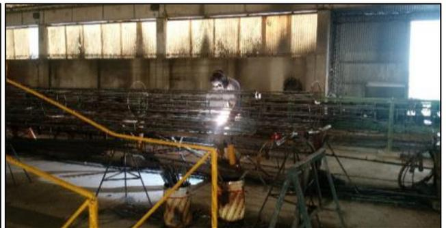
Foto 1.14 - Soldadura de armadura pasiva
