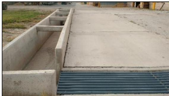
Foto 1.75 - Conducto pluvial con placas premoldeadas
