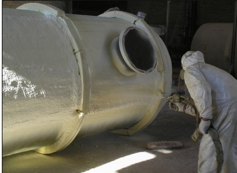
Fig. 9.66: Aplicación de un revestimiento de poliuretano expandido.
