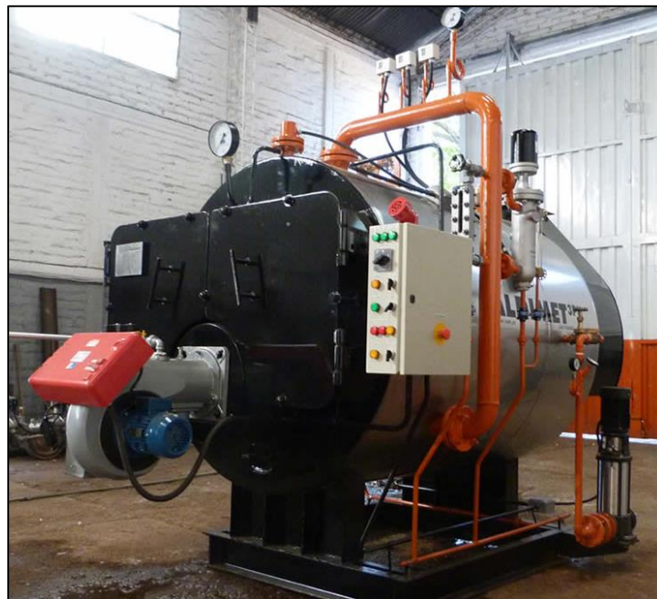
Fig. 9.117: Caldera generadora de vapor, modelo 3 HP.
