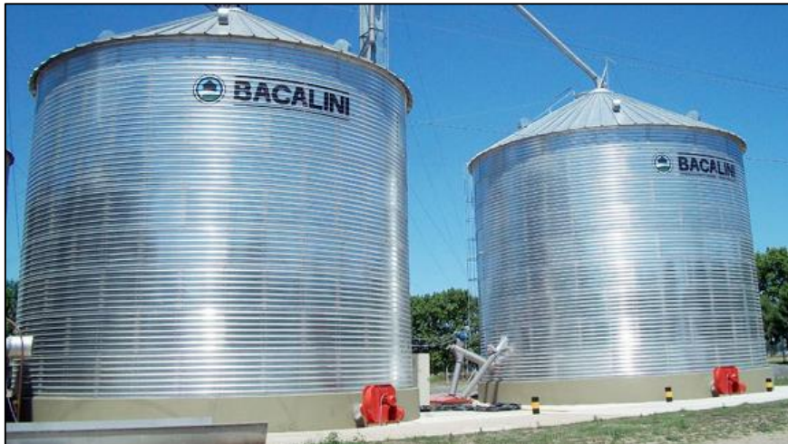
Fig. 5.11: Silos verticales de fondo cónico con base de hormigón.
