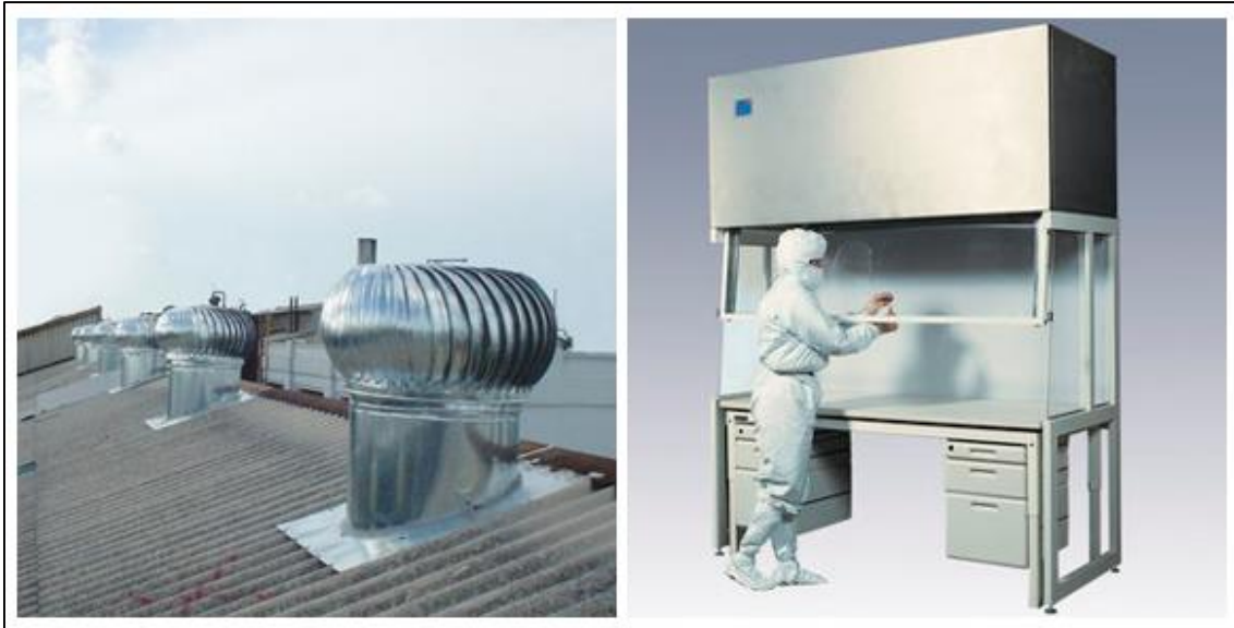
Fig. 12.25: A la izquierda, campanas extractoras para techos. A la derecha, cabina de laboratorio.
