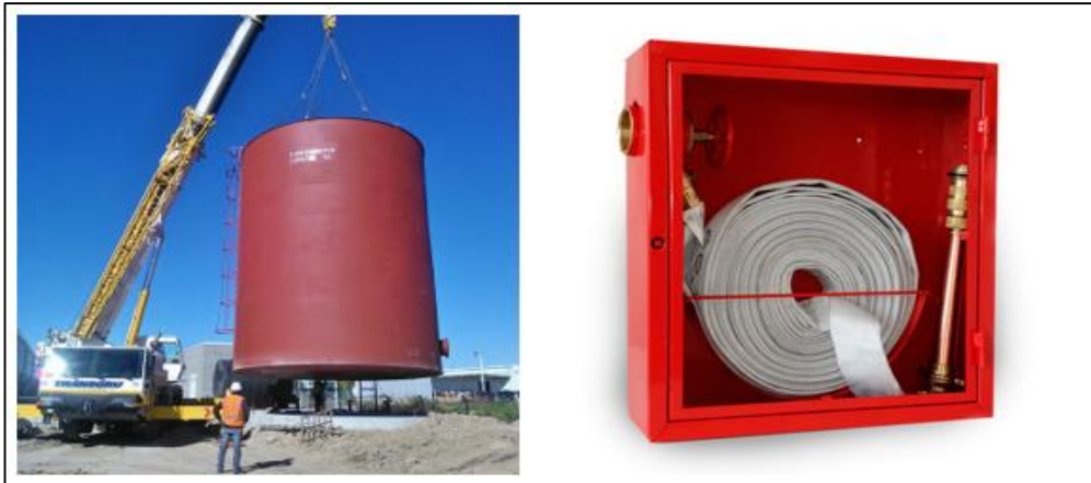
Fig. 12.3: A la izquierda, tanque de reserva contra incendio. A la derecha, nicho hidrante.
