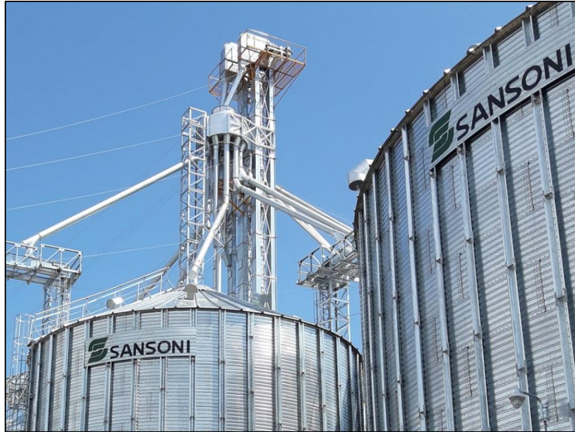
Fig. 9.50: Elevador de cangilones con sistema de distribución para silos.
