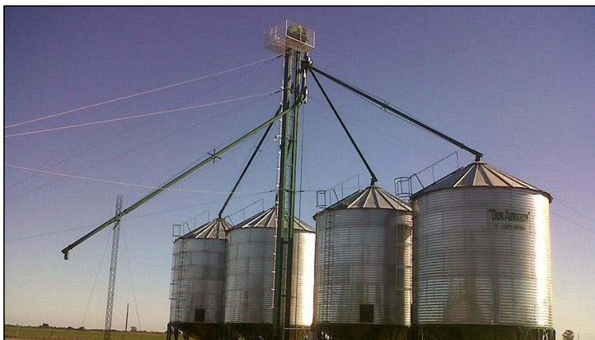
Fig. 5.10: Noria elevadora para el llenado de silos.
