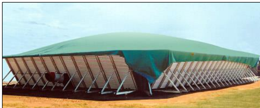
Fig. 5.7: Lona protectora para silos tipo celda.
