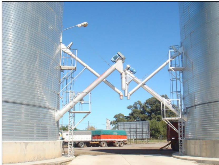
Fig. 9.51: Roscas extractoras instaladas en silos verticales.
