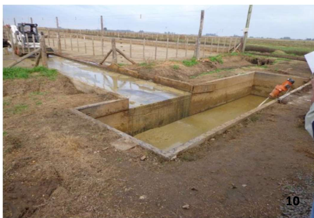
Foto Nro. 10: Barrido de efluentes hacia la cámara de recepción. Foto Nro. 12: Vista del digester con el sistema de agitación y ventilador de aire para membranas. Fuente: INTA- Informe de la visita al establecimiento "La Micaela" Feedlot en Carlos Tejedor, Provincia de Buenos Aires
