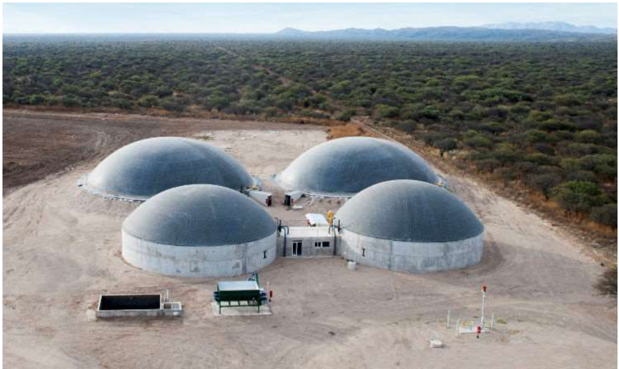
Foto Nro. 13: Planta de Biogás, establecimiento Yenketruz. Fuente: VIA Renovable. Noticias sobre energía renovables.
