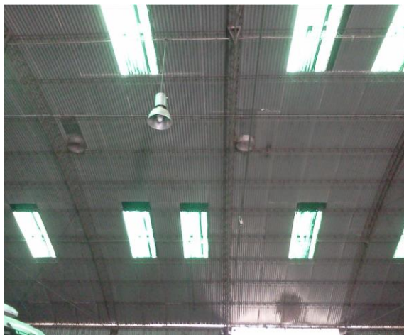
Foto nº 10. Iluminación de lámparas de sodio y chapa traslucida (deposito)
