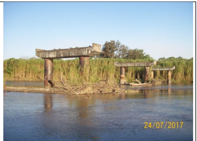
Foto 7: Vista de margen derecha desde altura del vertedero de RSU (Transecta 6)
