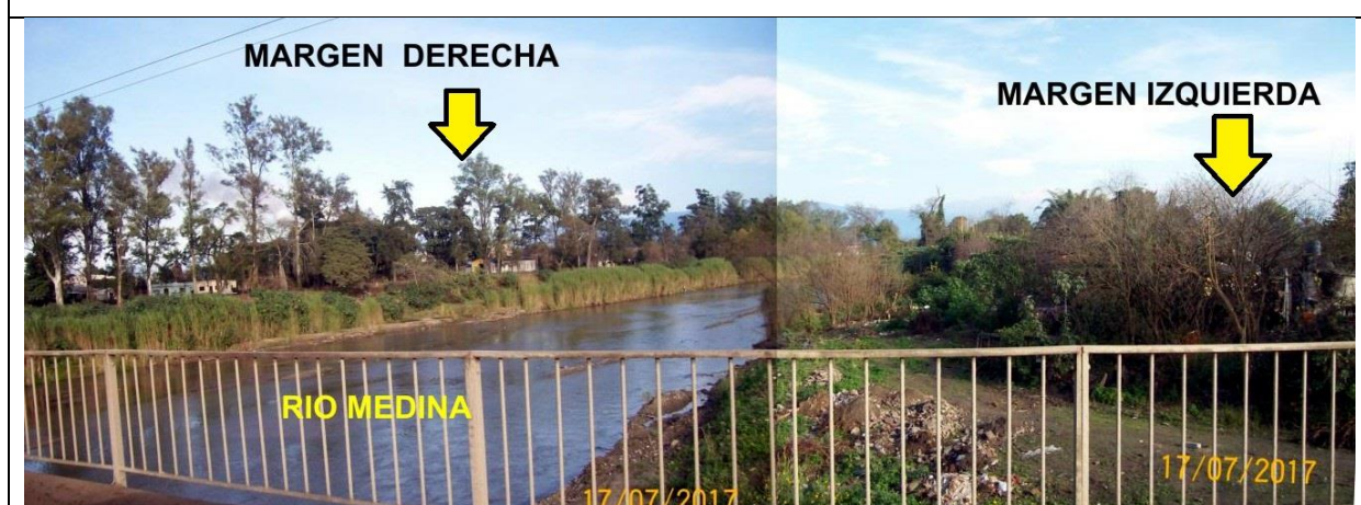
Foto 9: Vista al Oeste –Sudoeste de ambas márgenes del Río Medina desde el puente carretero nuevo (Transecta 4).
