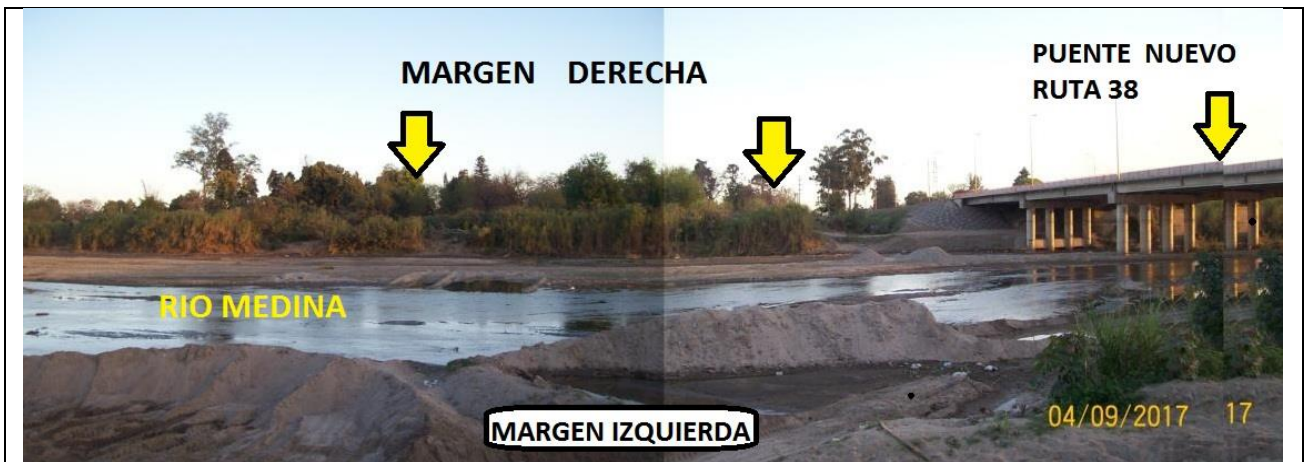
Foto 1: Vista al sur desde margen izquierda mostrando obras de canalización (Transecta 4)
