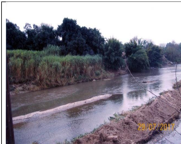
Foto 6: Vista de margen izquierda desde puente ferroviario (Transecta 1)
