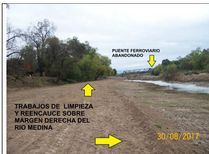
Foto 10: Vista al oeste mostrando trabajos de limpieza sobre margen derecha (Transecta 1)
