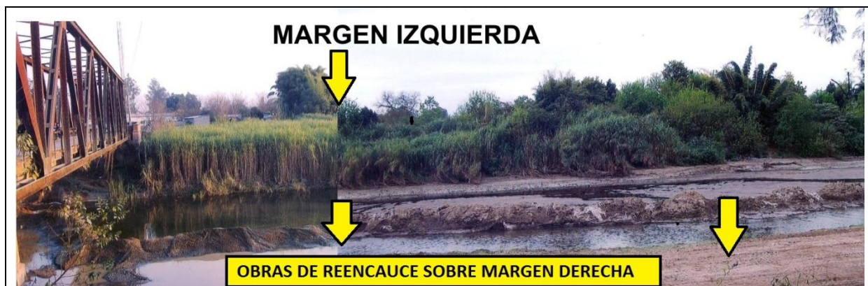
Foto 8: Vista al sur de margen izquierda y obras de reencauce sobre margen derecha en la zona del viejo puente carretero (Villa Nueva) (Transecta 2).
