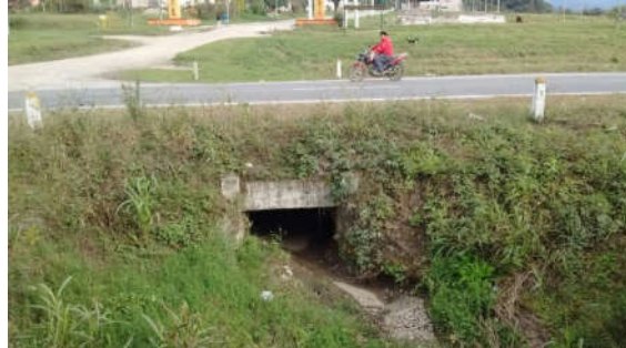
Figura 40: Alcantarilla (d) Ruta 9
