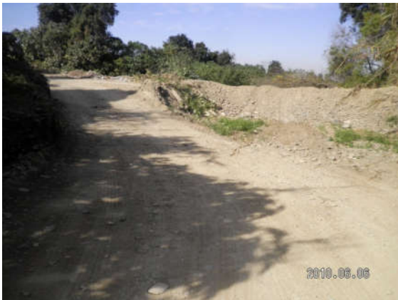
Figura 31: Terraplén y camino en el lecho del Río Caínzo
