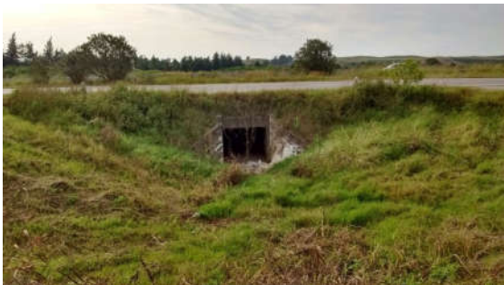
Figura 39: Alcantarilla (c) Ruta 9
