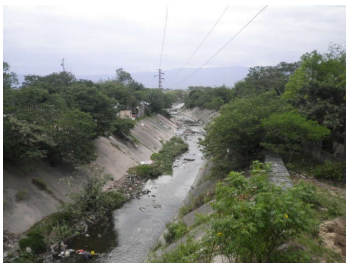
Figura 48: Canal Muñeca con depósito de partículas pequeñas y detritos con material orgánico.
