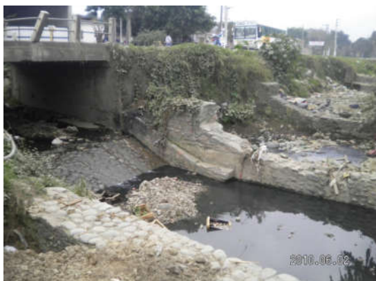
Figura 25: Puente sobre Ruta 315 que cruza A° Quebrada 6. Derecha, A° paralelo a la Ruta 315.
