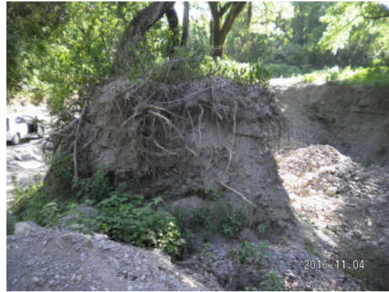
Figura 57: Excavación del suelo rodeando ejemplares de bosque nativo. Entre T. 2 y T. 3
