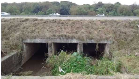
Figura 12: Alcantarilla (a) Ruta 9, km 1303
