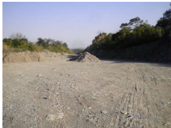
Figura 32: Calzada para transitar sobre el cauce del Río Caínzo. Explotación de áridos.
