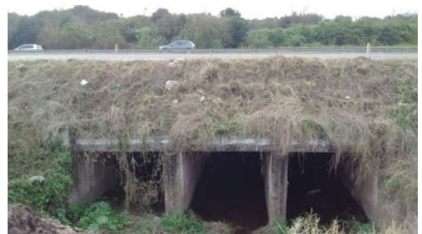
Figura 13: Alcantarillas (b) Ruta 9, km 1303
