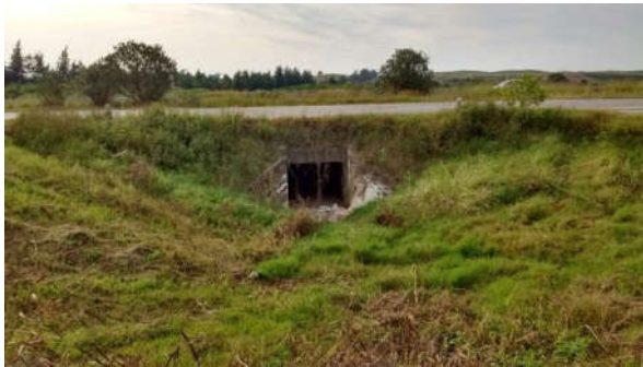
Figura 10: Alcantarilla Ruta 9, km 1306
