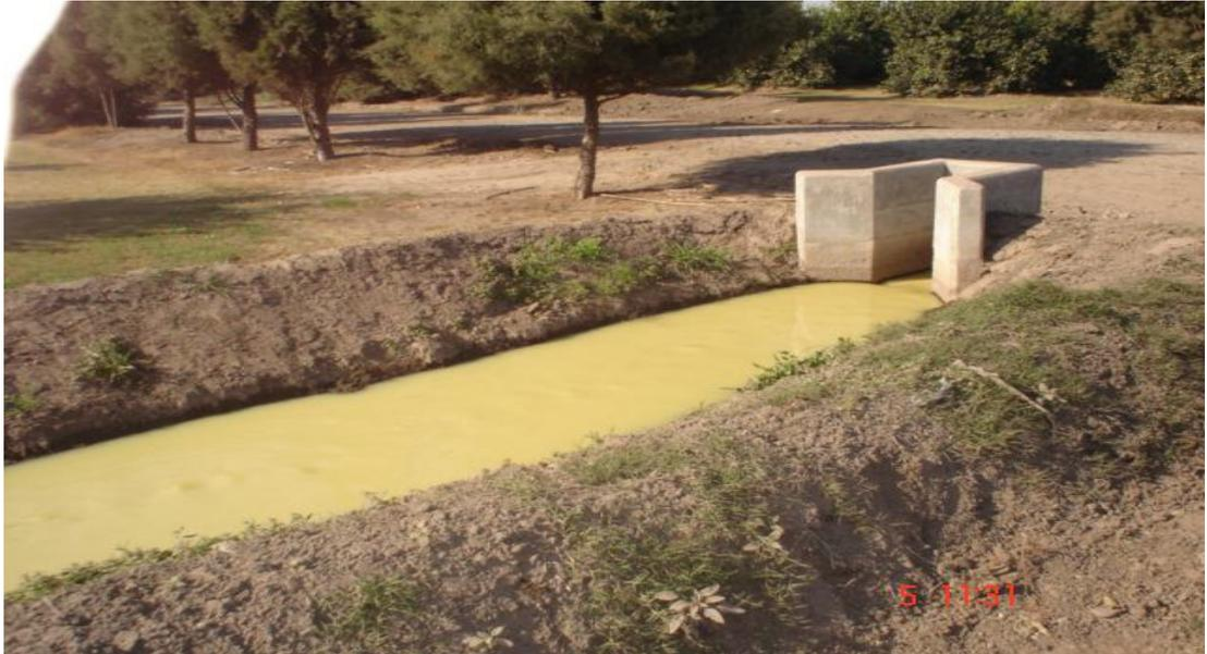
**Foto 10: Canal de conducción de los efluentes de una citrícola para riego.**
