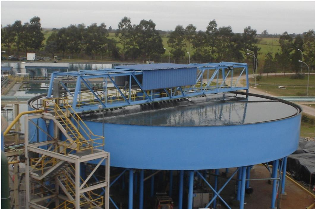
**Foto 31: Sedimentador circular en funcionamiento.** Gentileza La Alumbraera.
