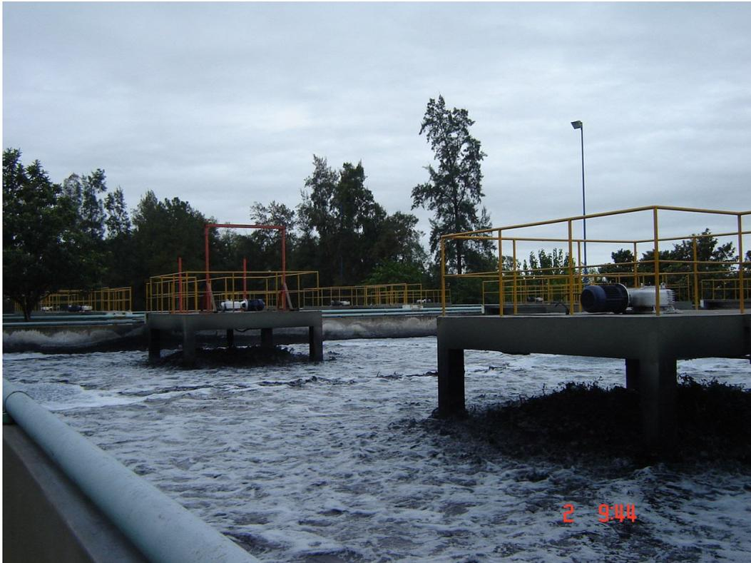
**Foto 3: Reactor biológico de un sistema de barros activados funcionando para el tratamiento de efluentes industriales con aireadores de superficie.**
