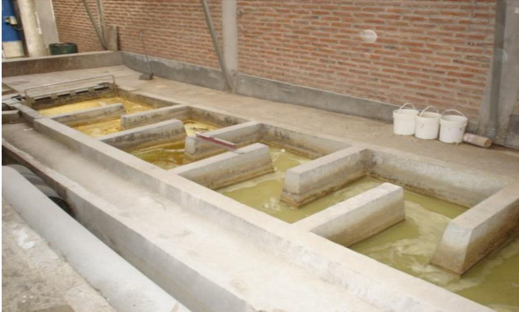
**Foto 11: Encalado del efluente, se observa el cambio de color progresivo en la cámara de mezcla por el contacto entre este y la cal. Gentileza Citromax.**
