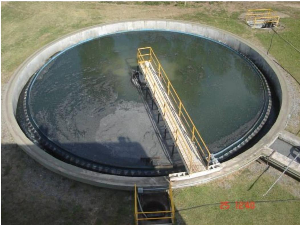
**Foto 7: Sedimentador circular funcionando.** Gentileza Arcor.
