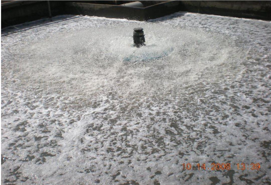
Foto 26: Área de Oxigenación cubierta por un aireador superficial de eje vertical.
