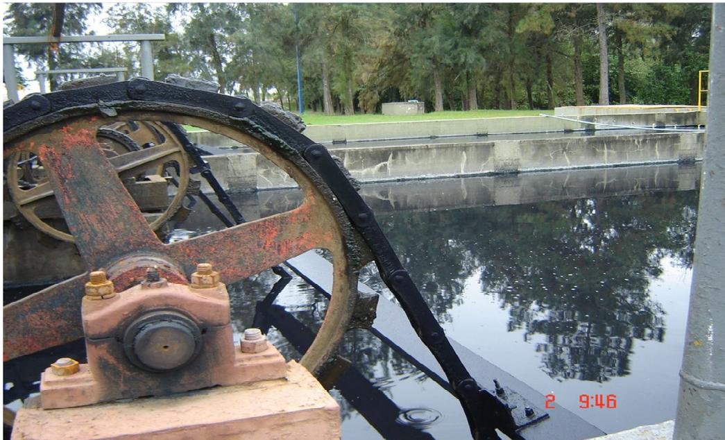
**Foto 5: Sedimentador secundario rectangular con las aspas que se desplazan muy lentamente y arrastran los barros en el fondo. Gentileza Grafa SA.**
