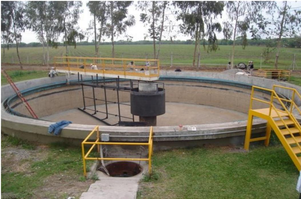
**Foto 6: Sedimentador circular, los barros se acumulan sobre el fondo.** Gentileza Arcor.
