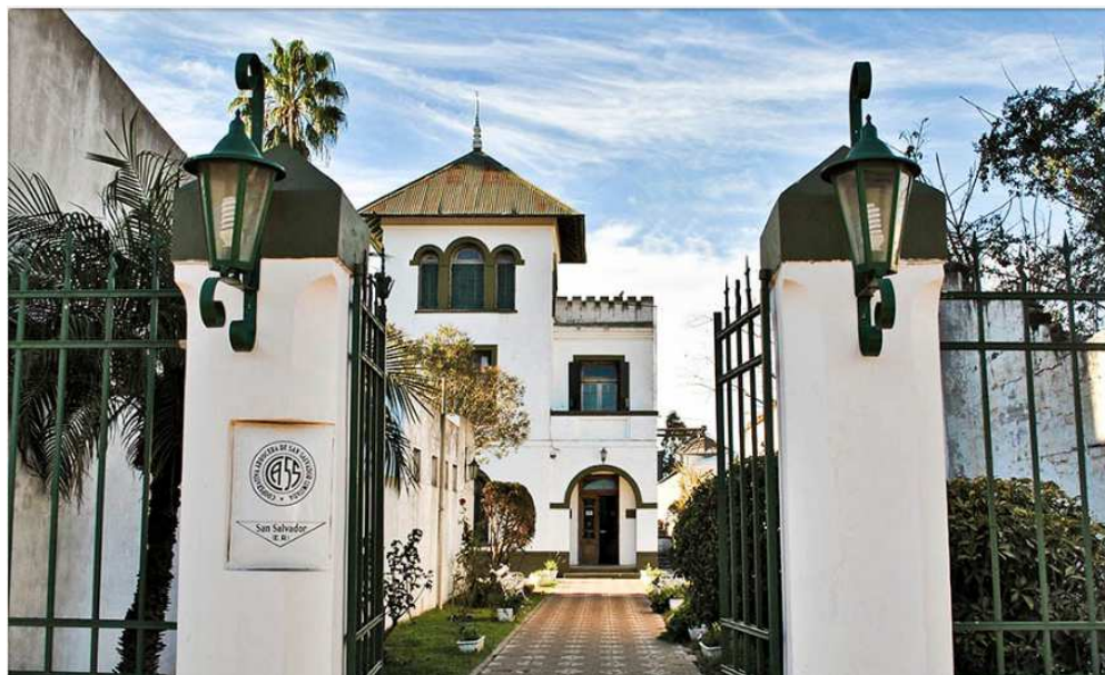
Fig. Nº 21 Cooperativa arrocera. Antigua residencia del fundador
