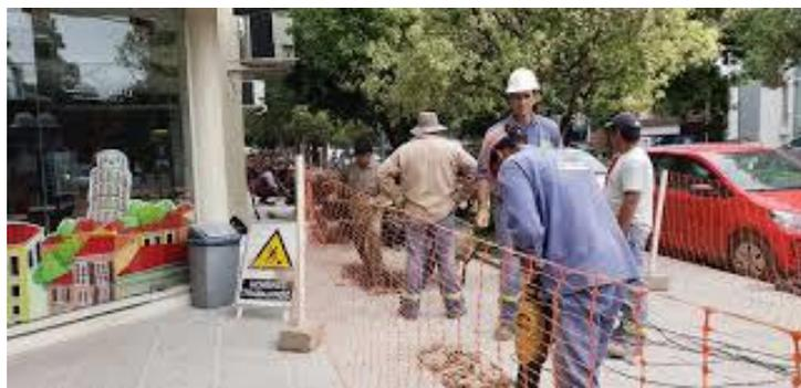
*Figura N°5: Remoción de veredas con martillo neumático*
