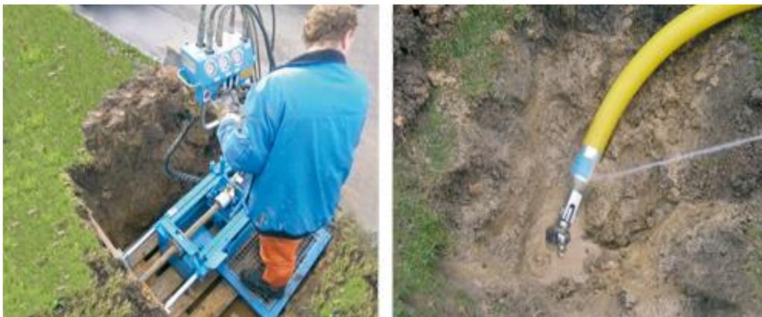
*Figura N°27: Ubicación de Grundopit e ingreso de la cañería al túnel.*
