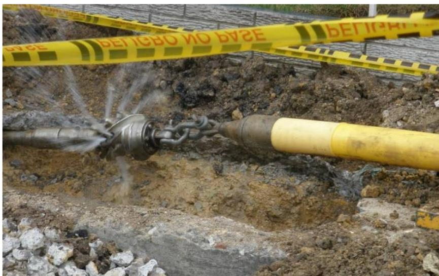
*Figura N°25: Retroceso del escariador e instalación de la tubería.*
