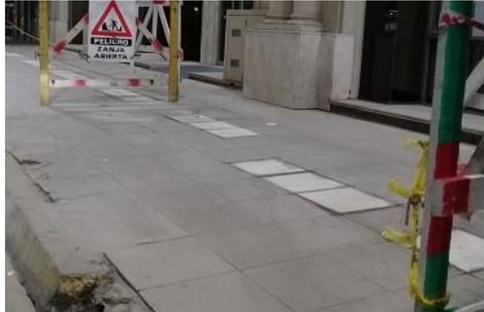
Figura N°14: Vereda reparada con acabado distinto al existente.
