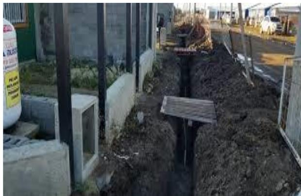
*Figura N°6: Excavación de zanja, vereda intransitable*
