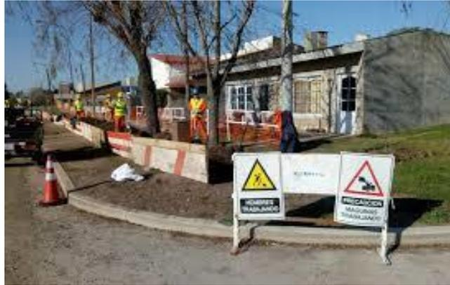
*Figura N° 4. Señalización y vallado.*
