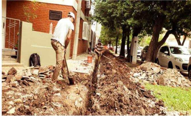
Figura N°7: Excavación de zanja en vereda sin vallado
