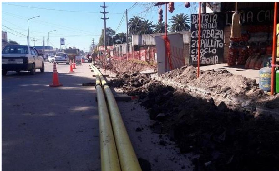
Figura N°8. Excavación de zanja en vereda (intransitable). 1/2 calzada ocupada con cañería.
