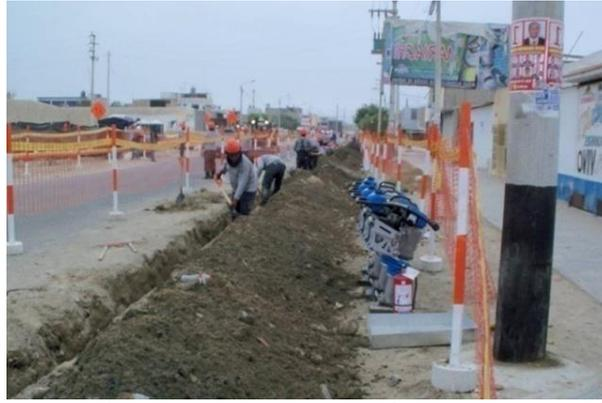
*Figura N°11: Tapada de cañería y compactación.*
