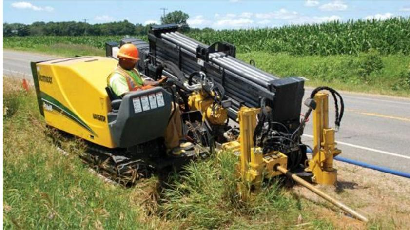
*Figura N°23: Tunelera Horizontal Dirigida*
