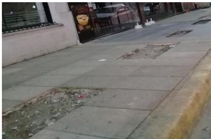
*Figura N°13: Vereda sin reparar y sin señalizar.*
