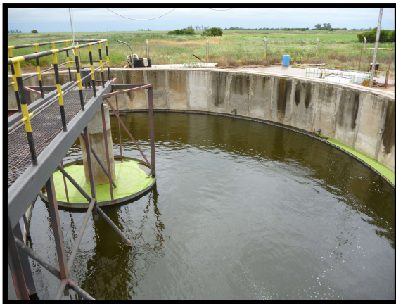
Fig. 4. Sedimentador de lodos
