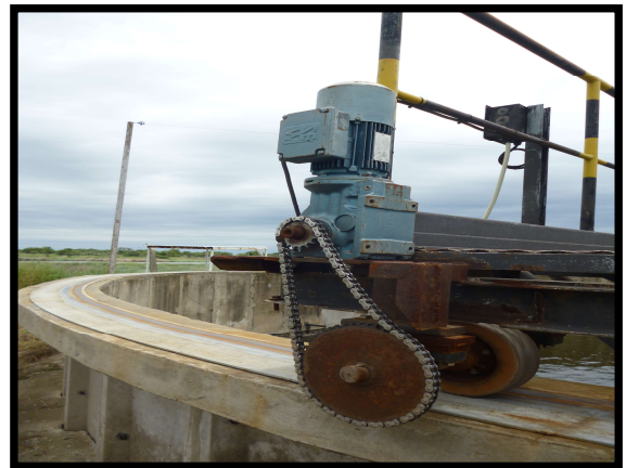
Fig. 5. Motor de carro barredor
