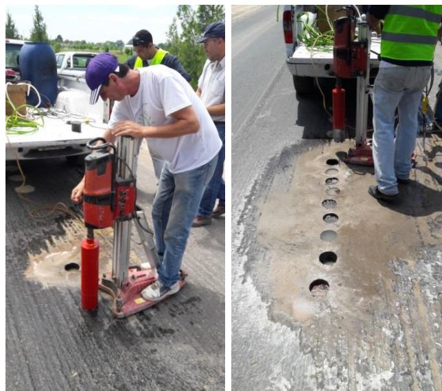
Figura 25. Extracción de testigos en sector en análisis
