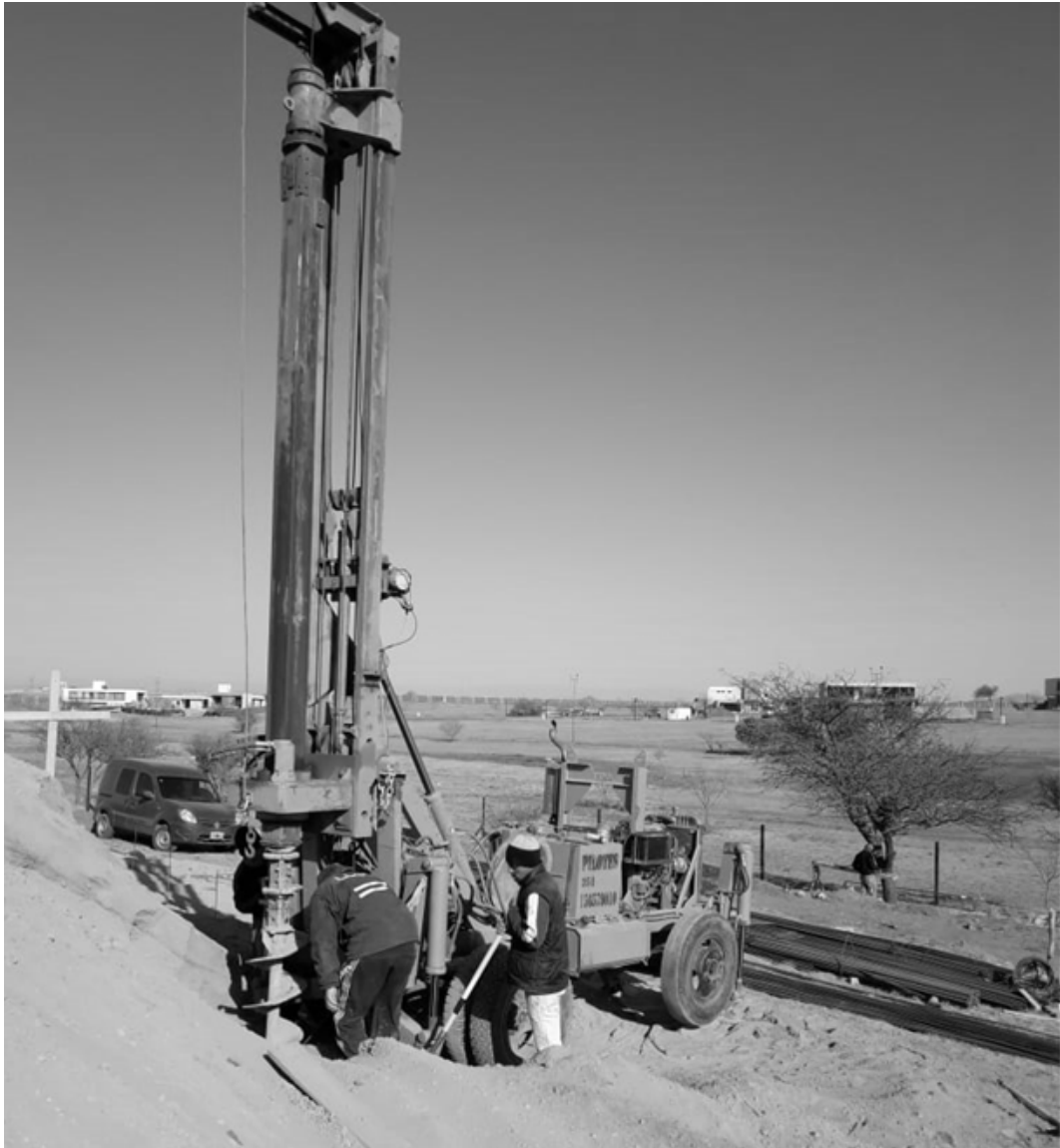
Figura 3: Excavadora rotativa – Pilotera, muestras Clase 3. (Cortesía: GEF Geotecnia, Estructuras y Fundaciones)
