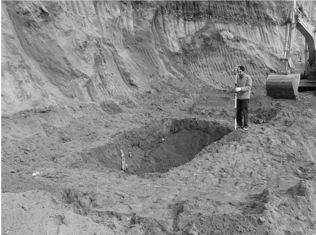
Figura 1: Calicata de exploración realizada con pala mecánica retroexcavadora
