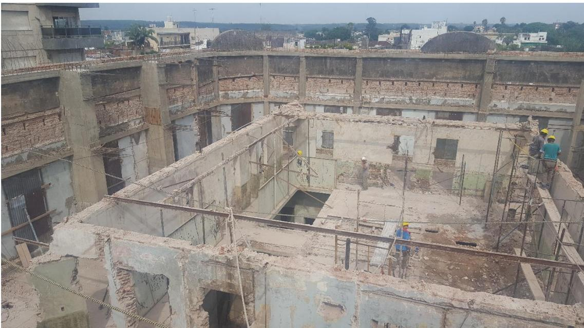
Figura N°10: Vista superior demolición de mamposterías, luego del retiro de cubiertas y de la estructura de arriostamiento de las fachadas
