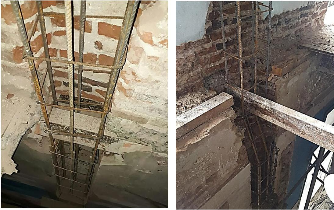
Figura N°9: Inserción de columnas en mampostería e intersecciones con estructura metálica existente
