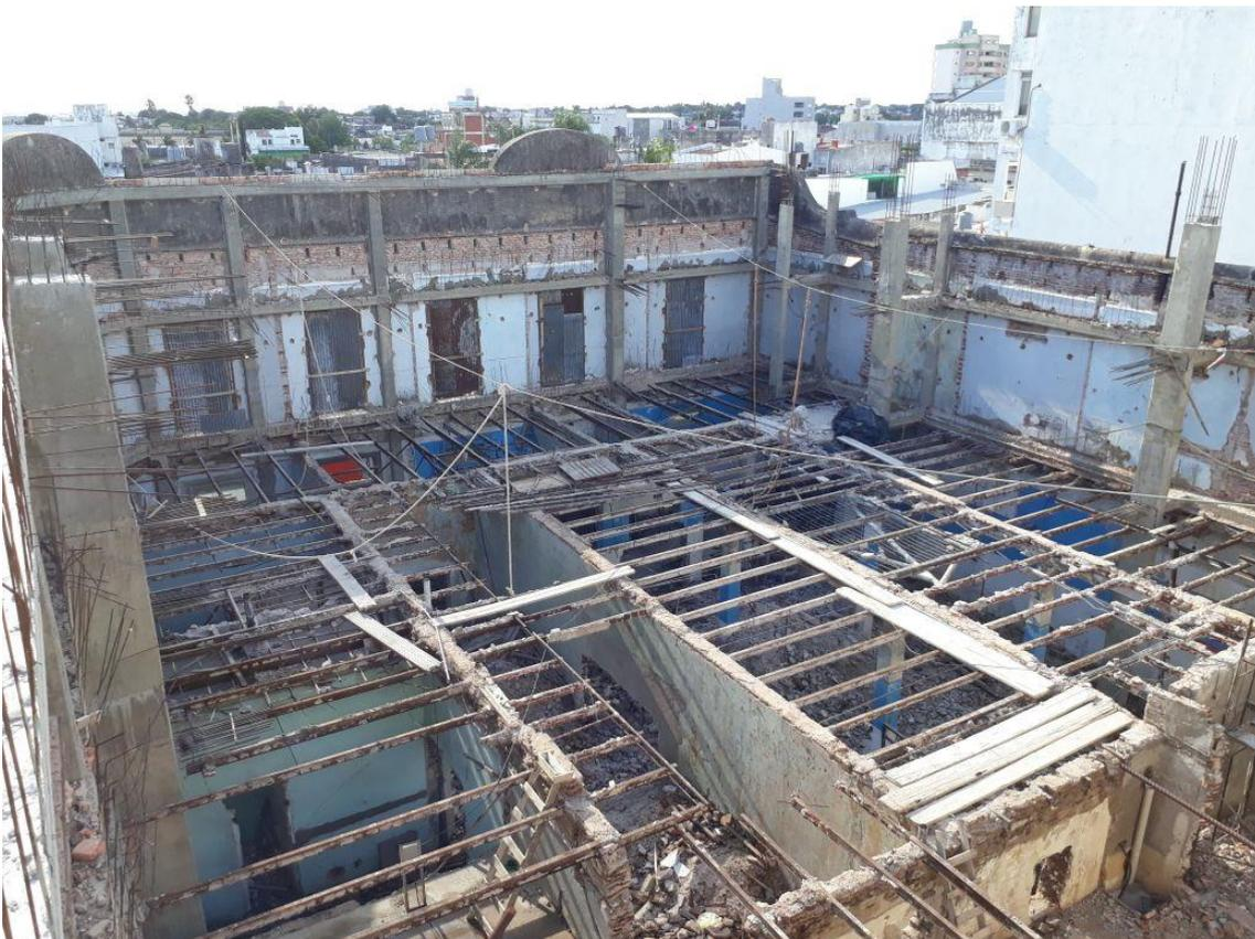
Figura N°12: Vista superior demolición de plantas internas y estructuras de refuerzos de fachadas
