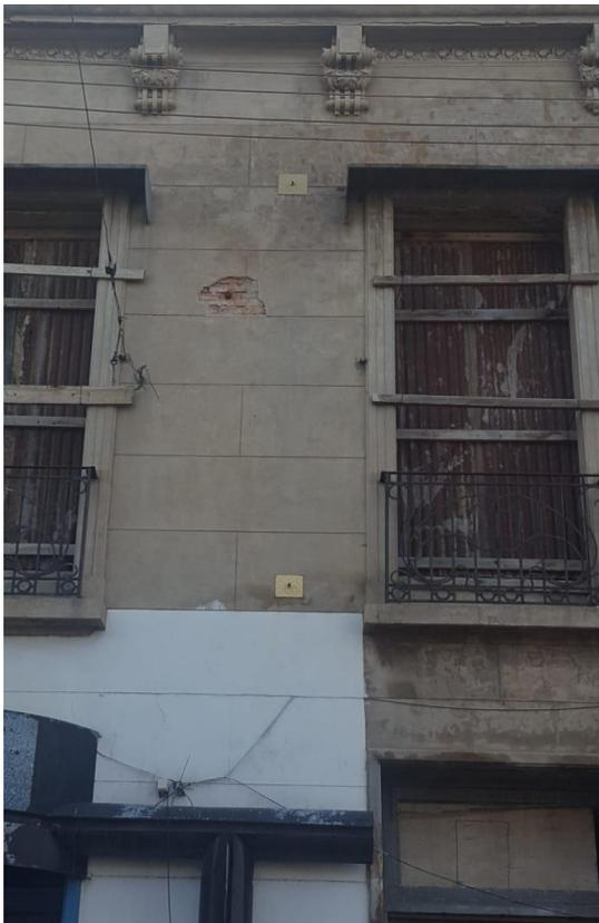
Figura N°8: Vista de insertos dispuestos en columnas de hormigón
