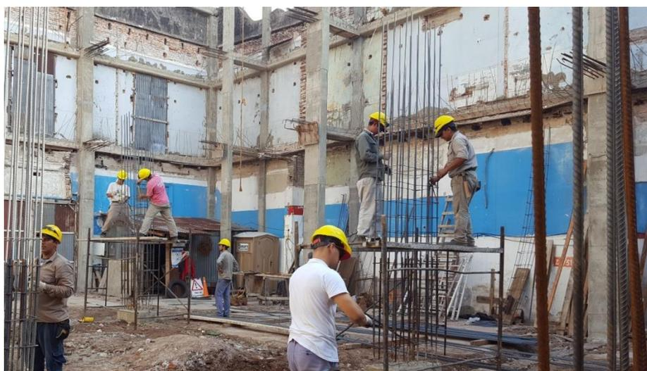
Figura N°5: Estructura de hormigón armado para la conservación de fachadas
