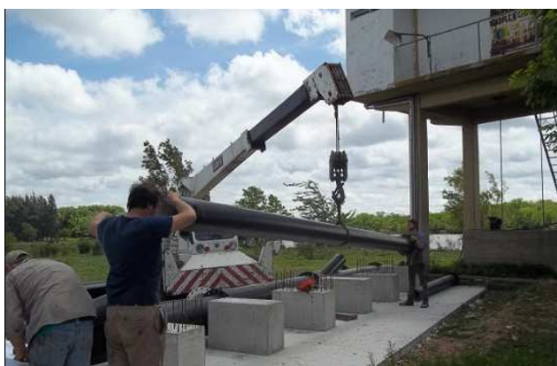
Río Gualeguaychú – Toma de agua para potabilización
