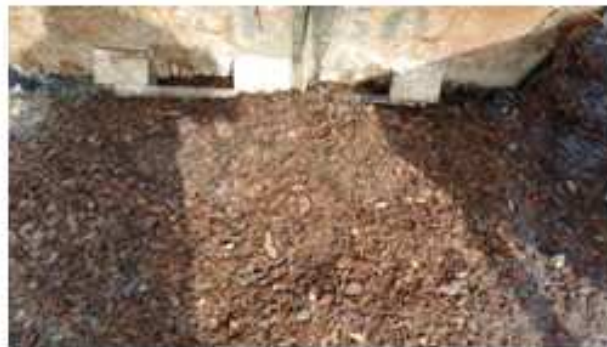
Contenedor con los residuos sólidos separados en el filtro grueso
