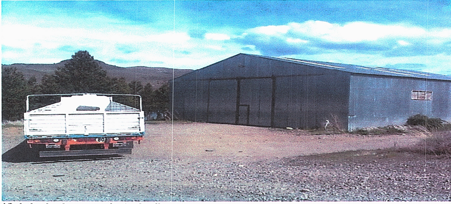
*Galpón de almacenamiento de alimento
