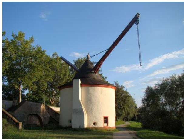
Fig. 1-3. Grúa sobre el río Mosela, Trier, Alemania
