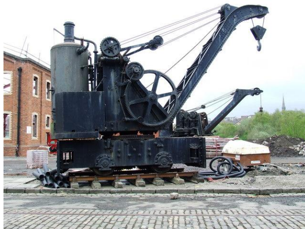
Fig. 1-4. Grúa de vapor
