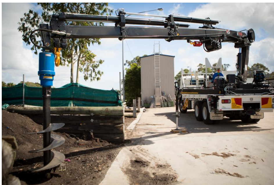
Fig. 2-1. Grúa con accesorio para perforación de suelos
