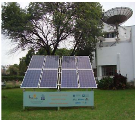
Figura 14: Sistema FV de 1,92 kWp instalado en la Asociación Argentina Amigos de la Astronomía. Fuente: artículo del CONICET
