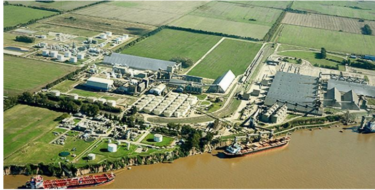
FIGURA Nº 8. Vista aérea del parque industrial de San Lorenzo, Santa Fe
