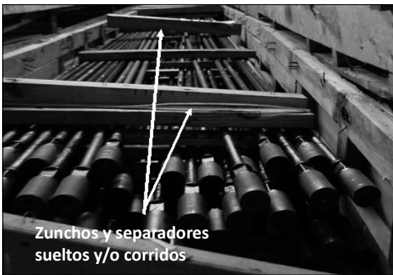
Figura 2. Paquetes de varillas fuera de su cajón protector y cajones desmantelados.
