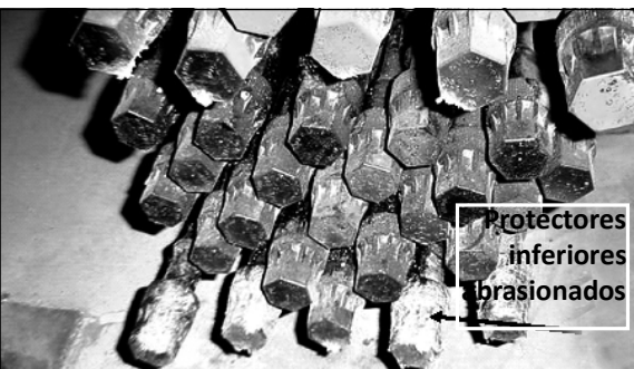
Figura 6. Los protectores de los filetes de rosca han sido girados para observar el deterioro por abrasión de los mismos.
